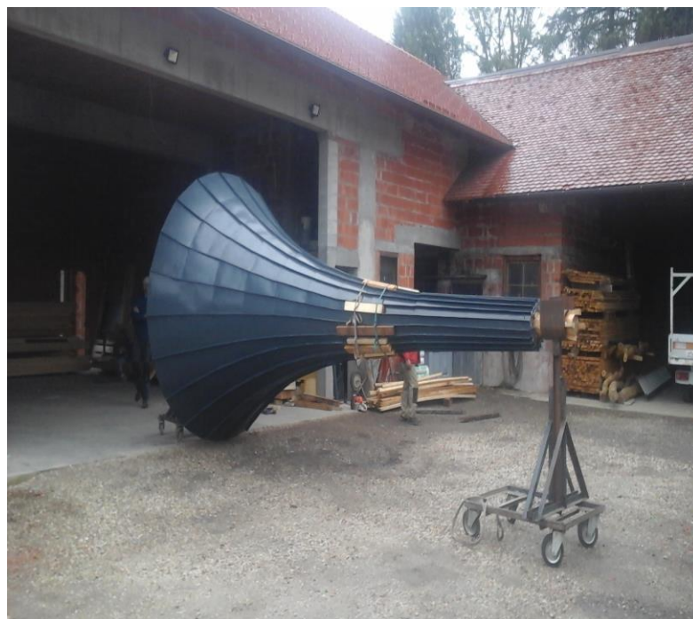
Slika 7: Stožčasti del novega stolpa, obdelan s šarami in alu barvno pločevino
