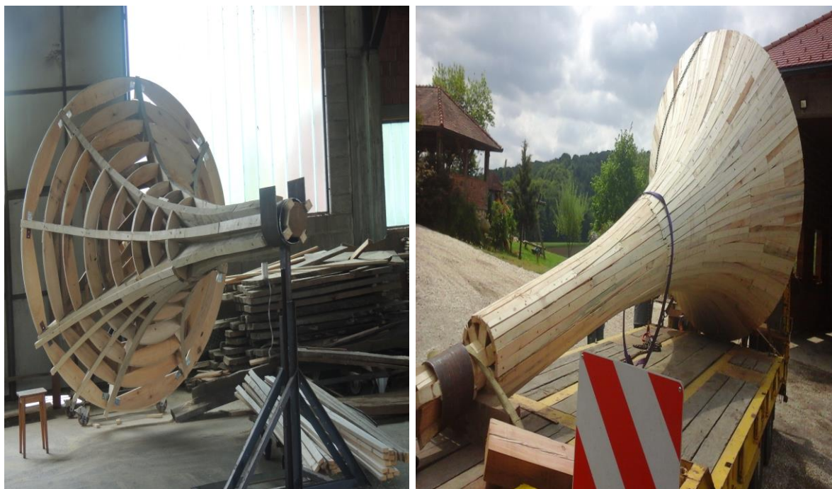
Slika 5: Konstruktivni element stolpa
