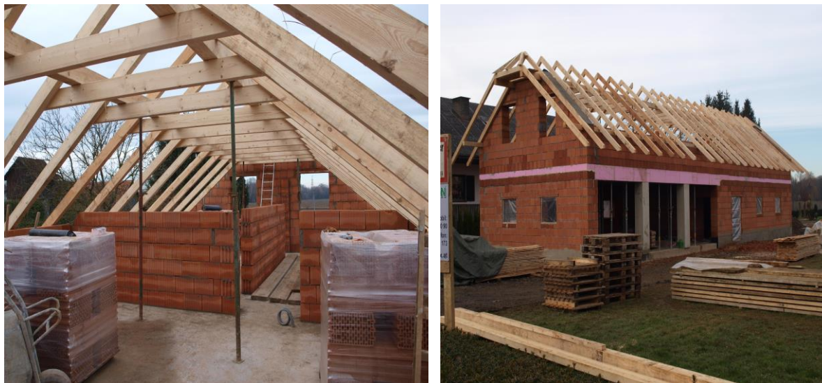
Slika 6: Enostavna dvokapna streha – roženice (goltniki), povezane s škarjami
