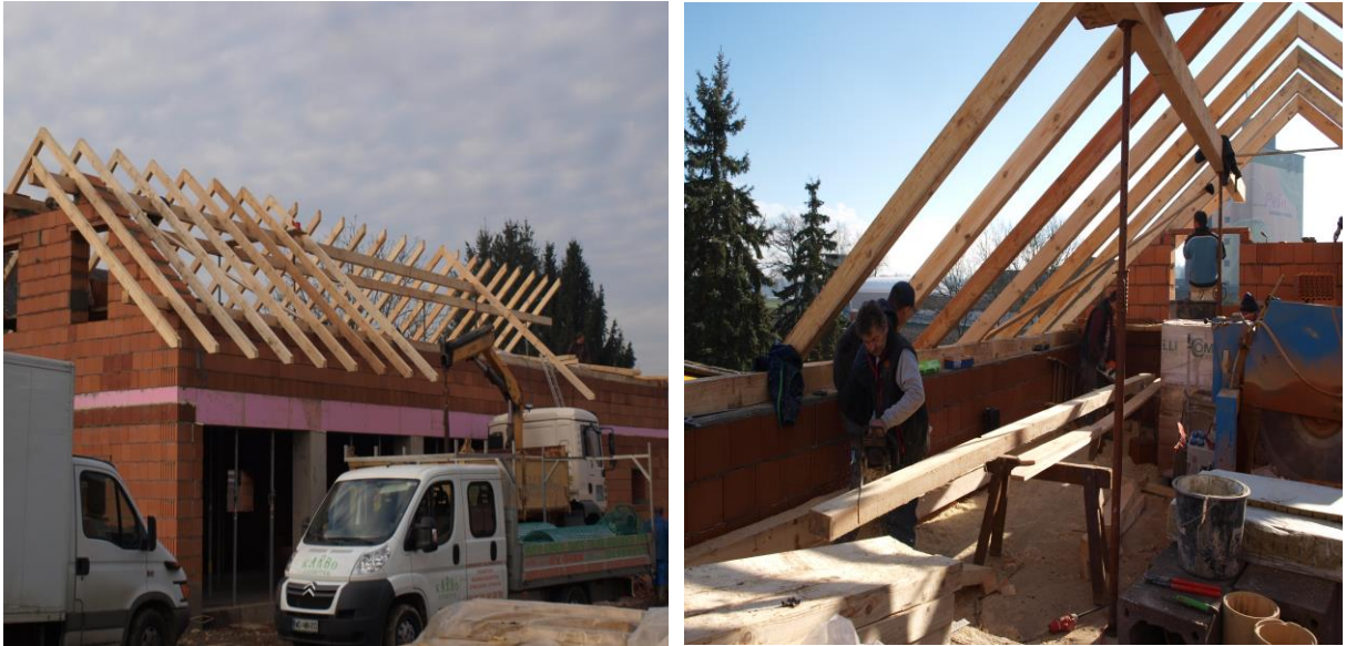
Slika 15: Ostrešje, izdelano na klasičen način
