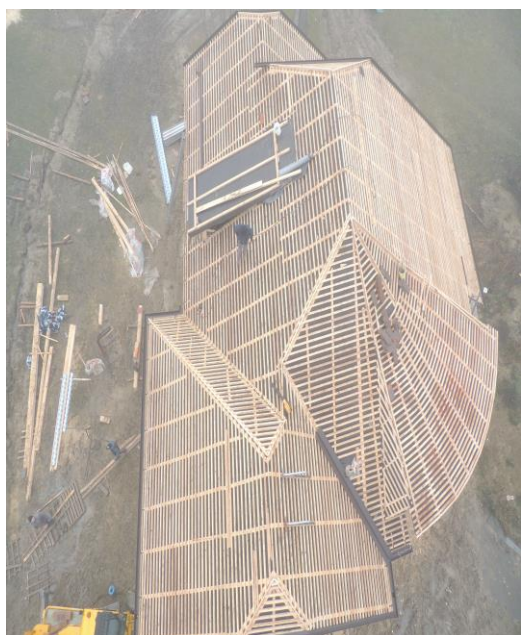
Slika 17: Konstrukcija ostrešja stanovanjske stavbe, izdelana na klasičen način, Hiša 1
