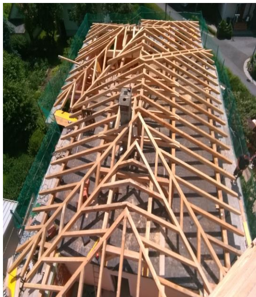
Slika 16: Konstrukcija ostrešja, izvedena s CNC-izrezom, Hiša 2
