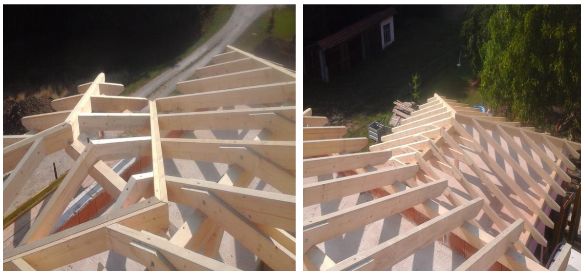
Slika 14: Ostrešje, izdelano z CNC
