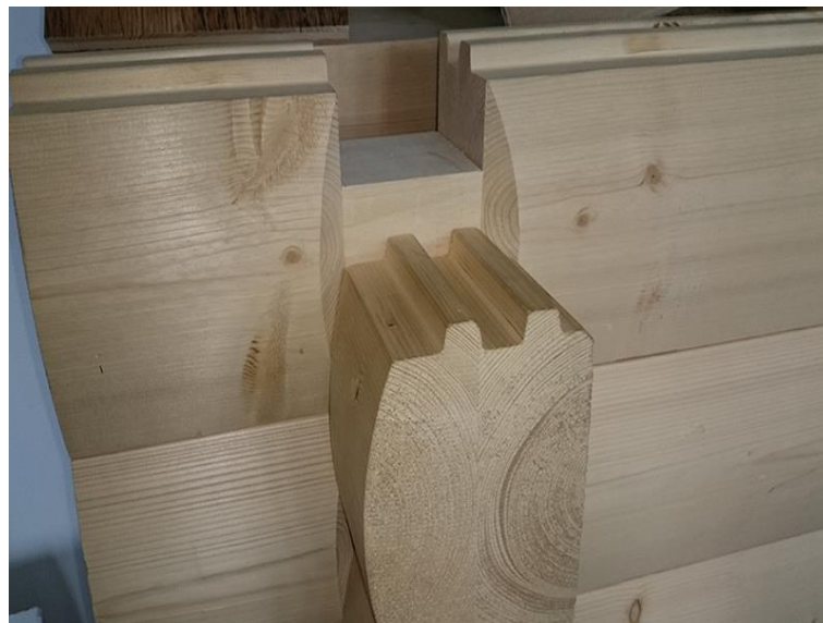
Slika 13: Strojno izdelana bruna sistema pero-utor
