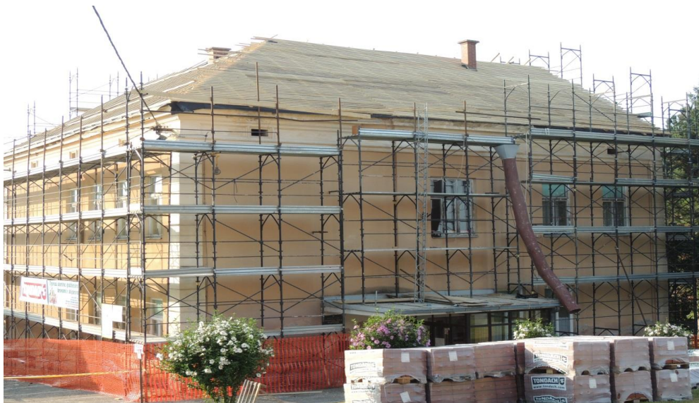
Slika 27: Primer postavitve varnostnega lovilnega odra na našem gradbišču (OŠ Ptujška Gora).
