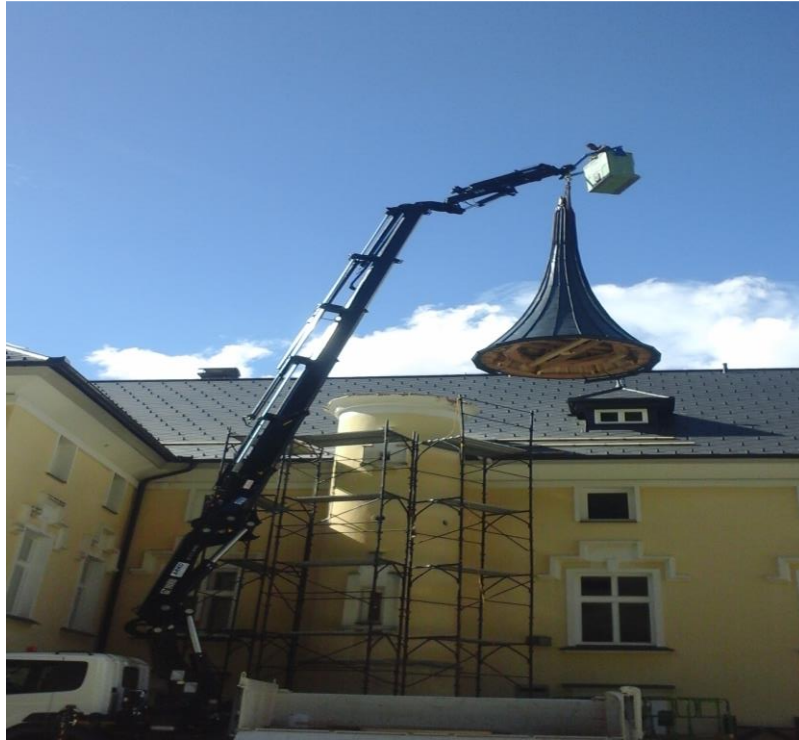
Slika 8: Nameščanje novo izdelanega stolpa na vrh graščine
