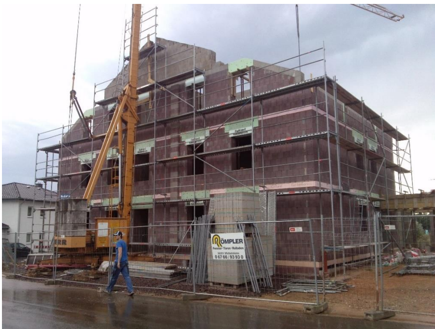
Slika 94: Objekt v Schwalbachu med postavljanjem delovnega odra
