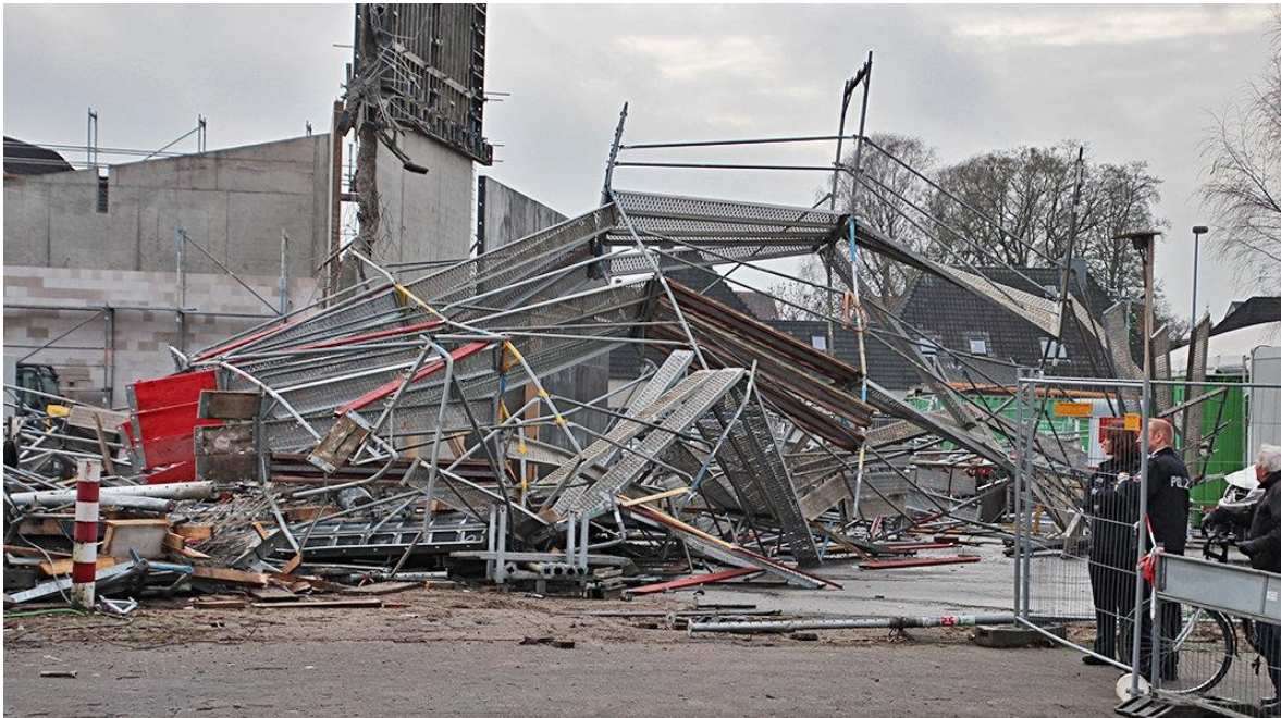
Slika 78: Porušen gradbeni oder v mestu Oldenburg v Nemčiji
