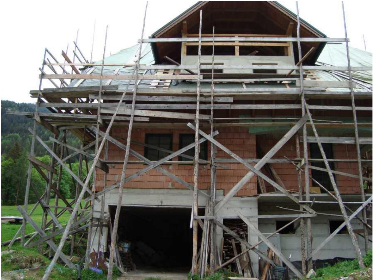
Slika 14: Prikaz lesenega delovnega odra na objektu
