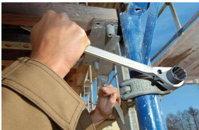
Slika 84: Ključ za montažo gradbenega odra
