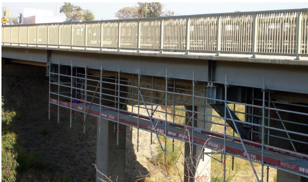
Slika 58: Viseč delovni oder na mostu
