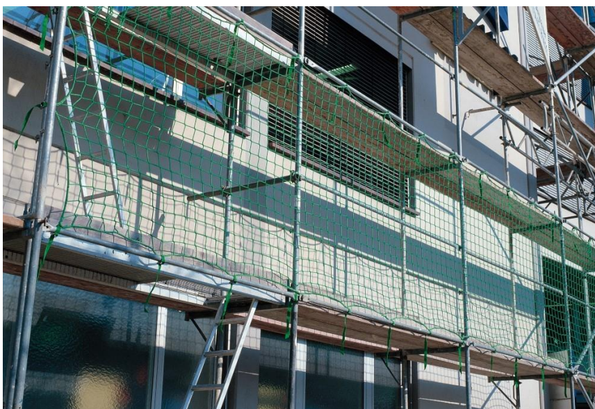
Slika 39: Primer fasadnega odra z varovalno mrežo
