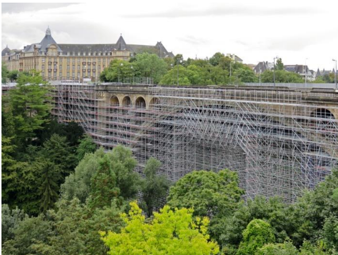
Slika 40: Modularni oder na primeru prenove mosta v Luksemburgu
