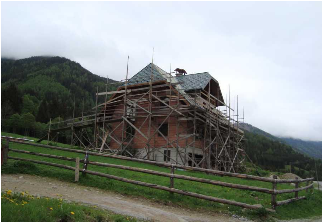
Slika 9: Prikaz lesenega delovnega odra na objektu
