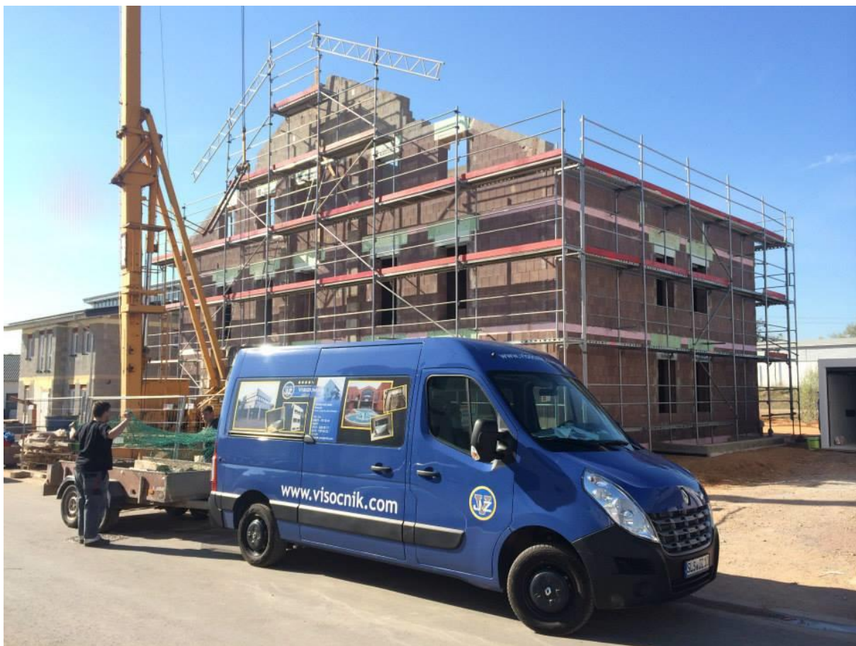
Slika 36: Primer postavljenega gradbenega odra
