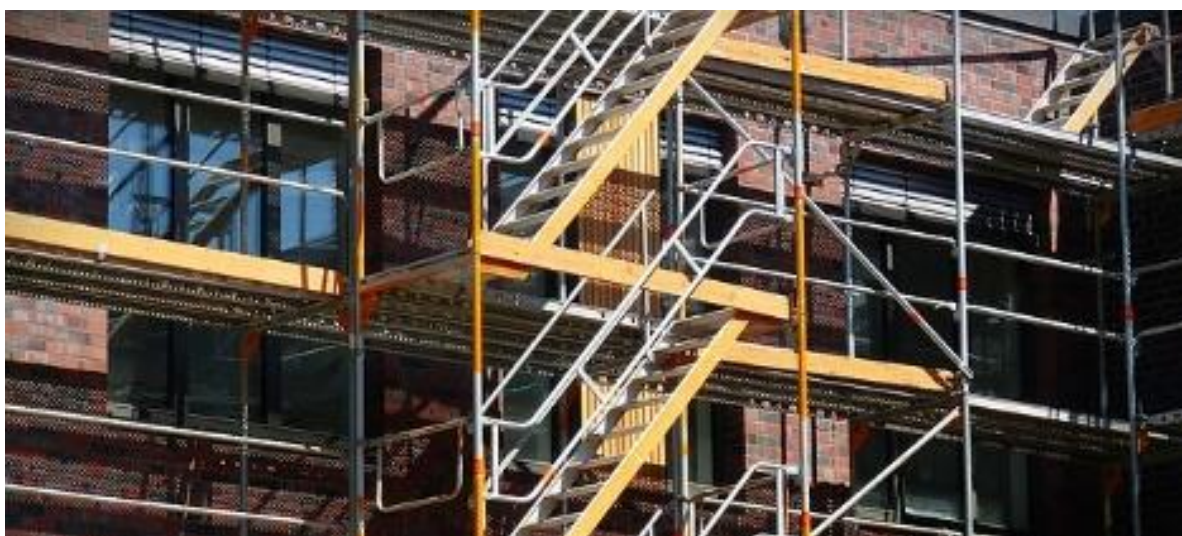
Slika 54: Stopniščna konstrukcija iz sestavnih delov fasadnega odra
