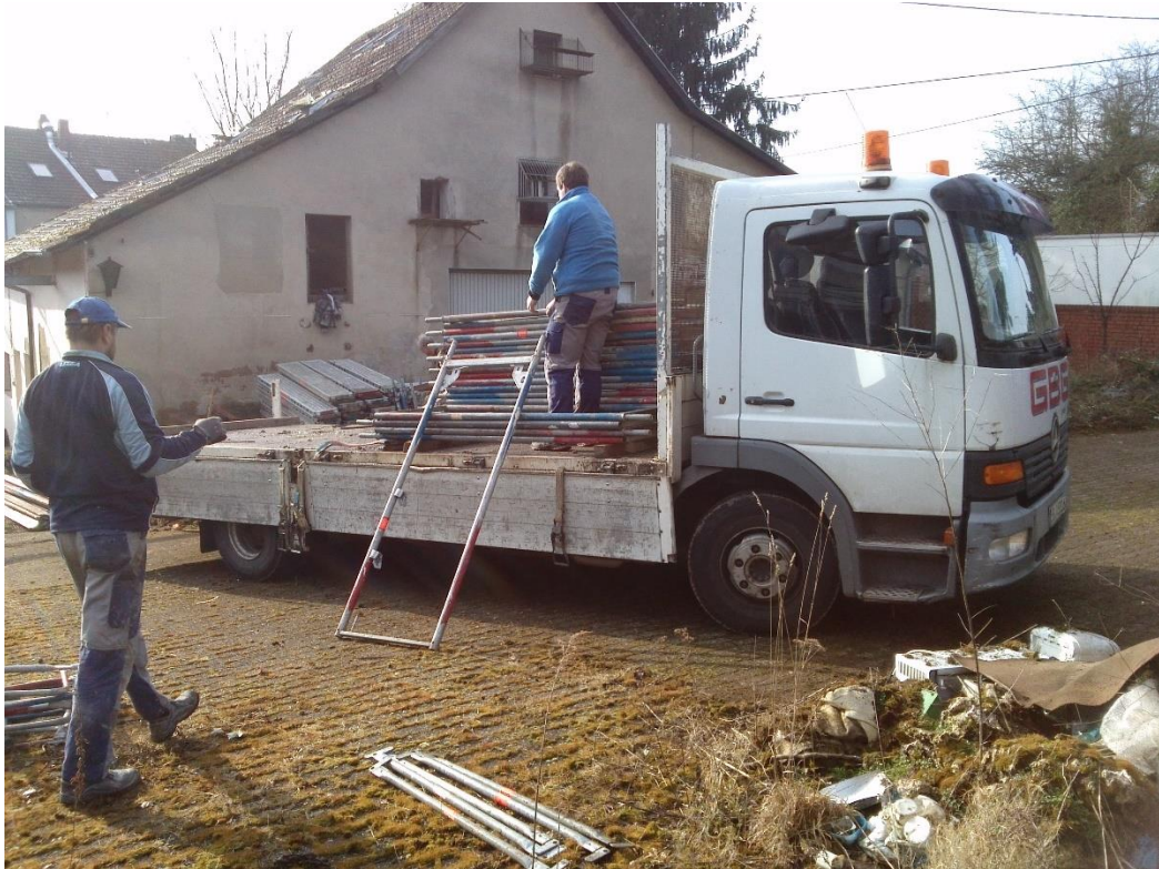
Slika 93: Prikaz nalaganja delovnega odra na prikolico
