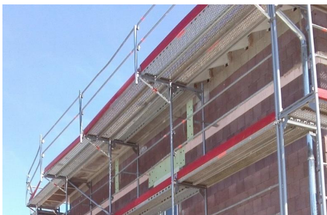
Slika 95: Razširitve na levi in desni strani objekta
