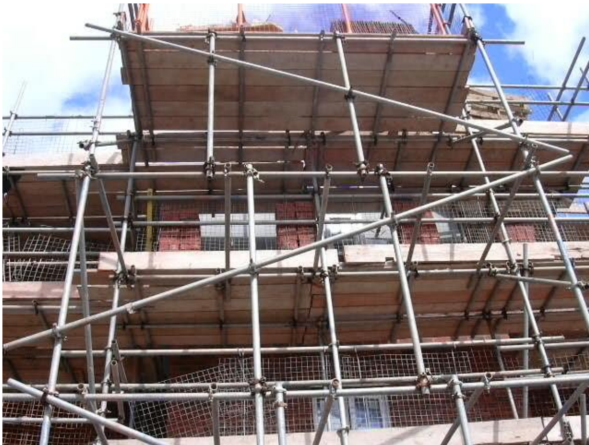
Slika 15: Prikaz cevnega delovnega odra na objektu
