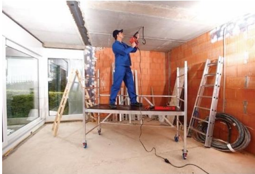
Slika 97: Delo na pomičnem odru Layher
