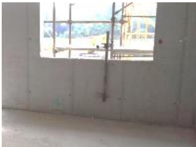
Slika 83: Prikaz sidranja gradbenega odra skozi odprtino
