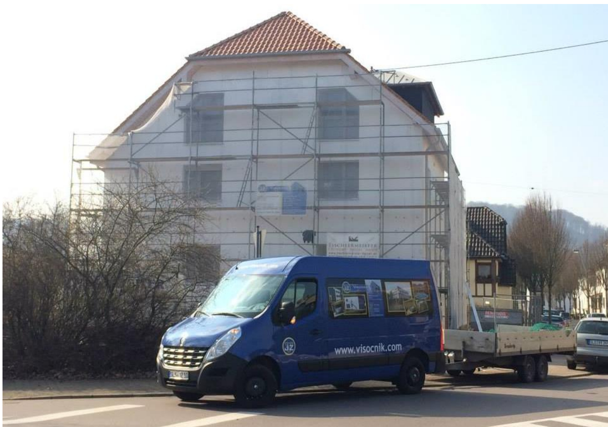
Slika 22: Prikaz fasadnega odra na objektu
