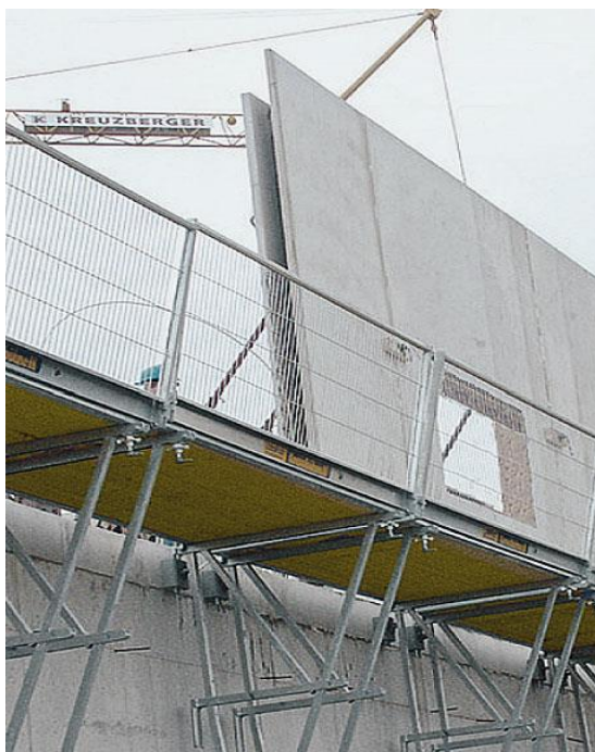
Slika 59: Primer konzolnega odra z varovalno ograjo
