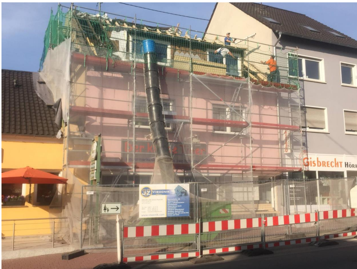
Slika 21: Prikaz zaščite pločnika
