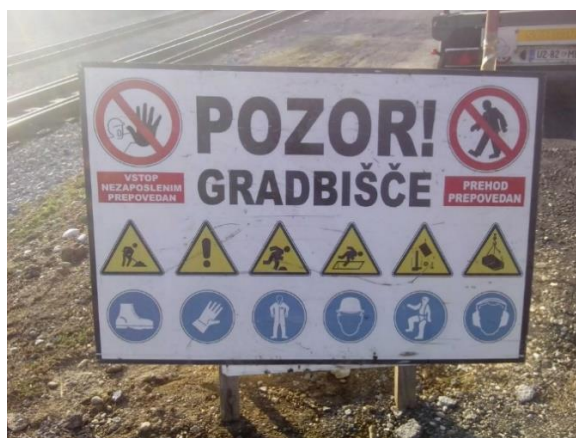
Slika 5: Opozorilna tabla na gradbišču
