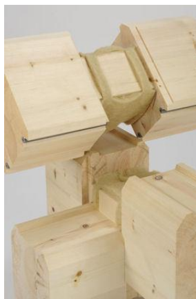
Slika 21: Križna vezava zunanjih in notranjih sten
