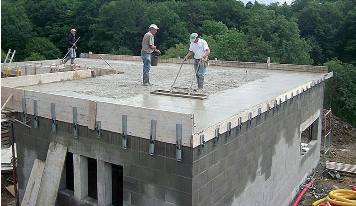
Slika 12: Izvedba medetažne stropne plošče
