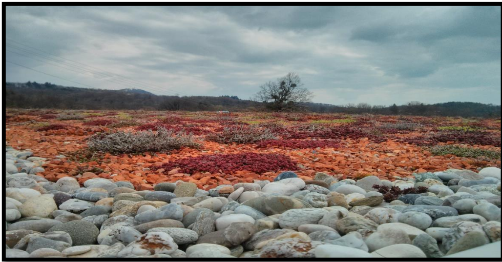
Slika 21: Prikaz izgleda zelene strehe (sedum, prodec, drobljena opeka)
