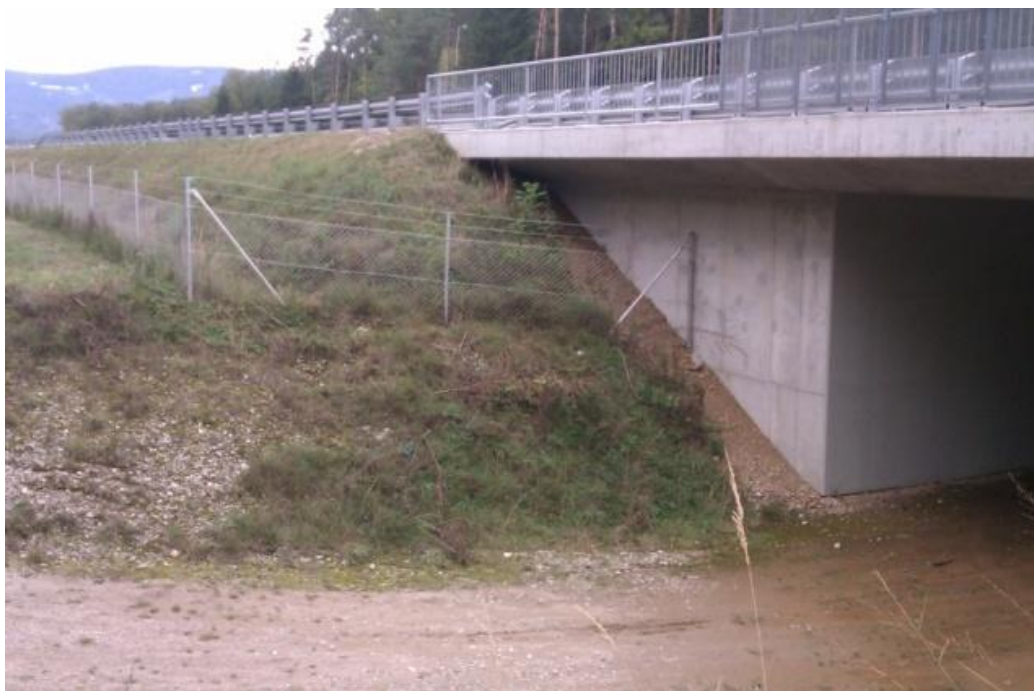
Slika 13: Brežina po zaključku gradnje
