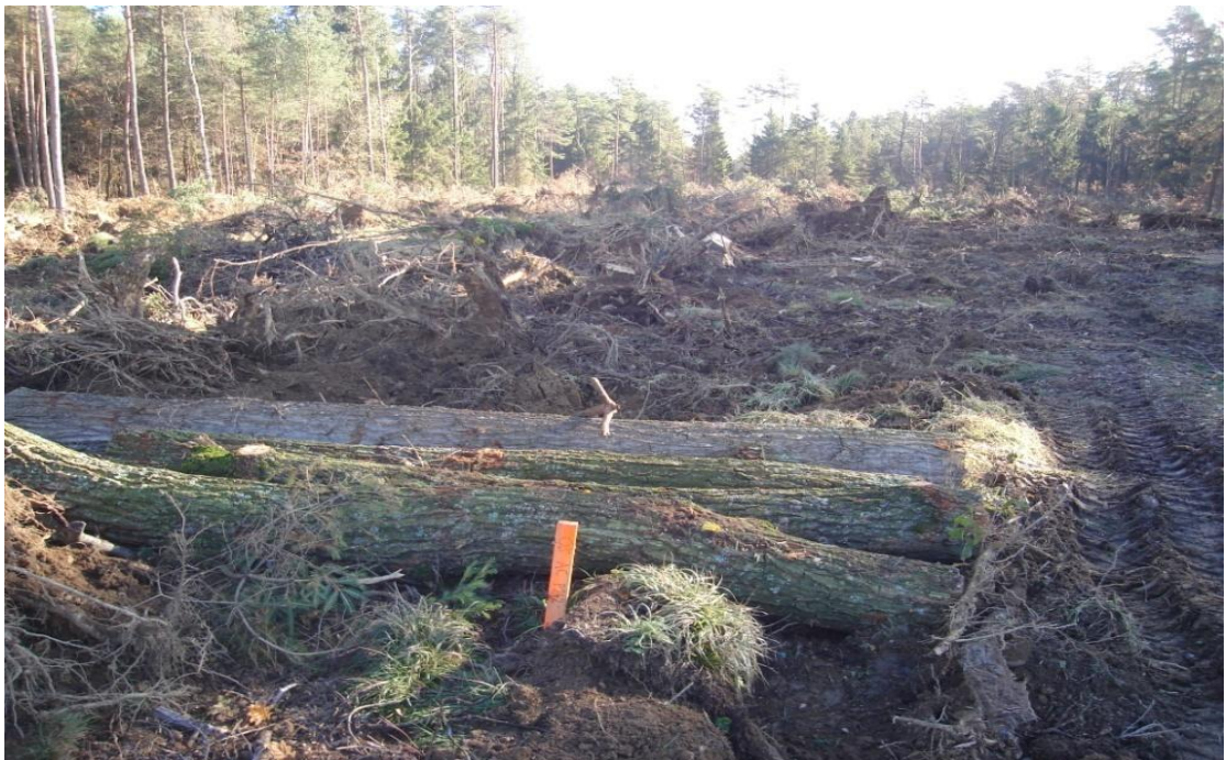
Slika 8: Posek in priprava terena
