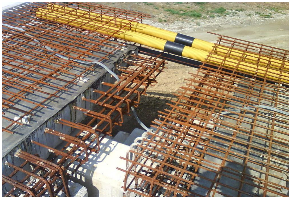
Slika 3: Stik prehodne plošče
