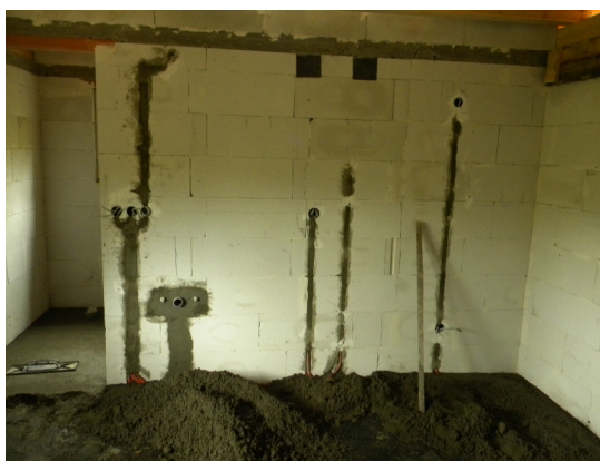
Slika 2: Izdelava estrihov s primerom zidarsko obdelanih utorov za strojne inštalacije
