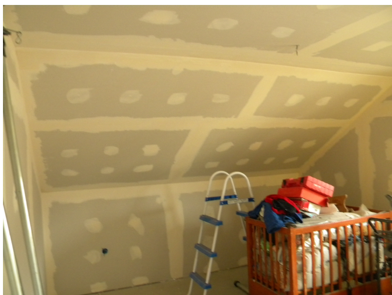
Slika 3: Mavčne plošče z obdelanimi stiki
