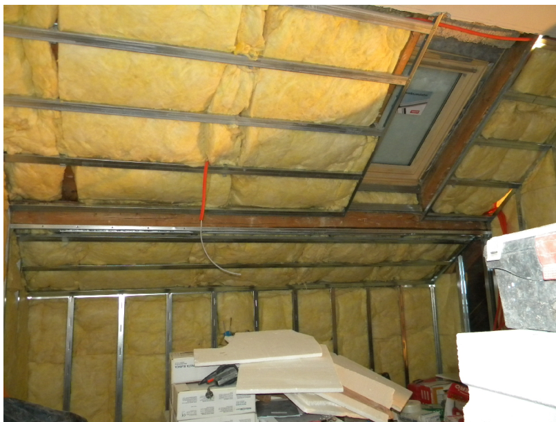
Slika 4: Podkonstrukcija za mavčne plošče – izolirano
