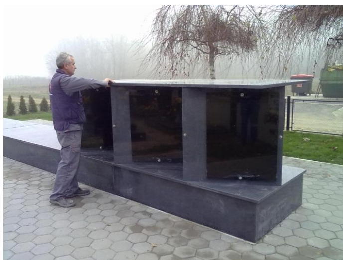
Slika 17: Postavljanje prvih treh žarnih niš
