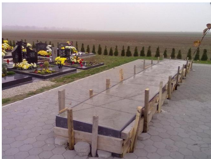
Slika 16: Zalivanje z betonom
