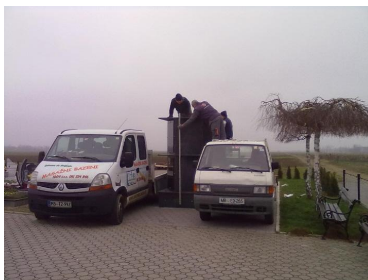
Slika 19: Sledi še zadnji del – streha. Pomagamo si z vozilom na vsaki strani Vir: Lasten
