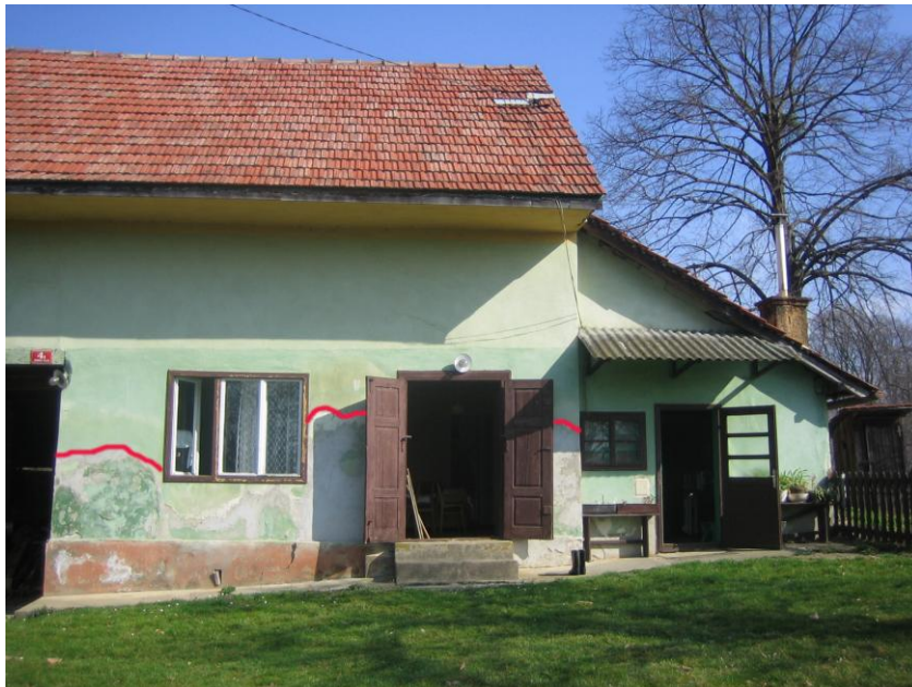
Slika 5: Vidno dviganje kapilarne vlage
