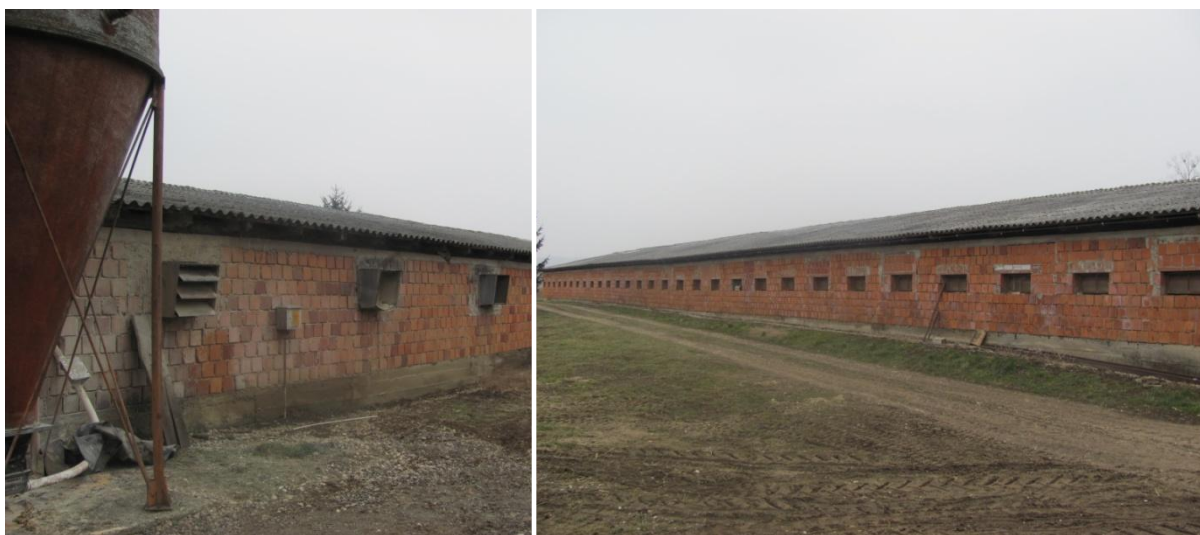
Slika 1: Vzhodna in zahodna fasada objekta predvidenega za rušenje Vir: Lasten vir
