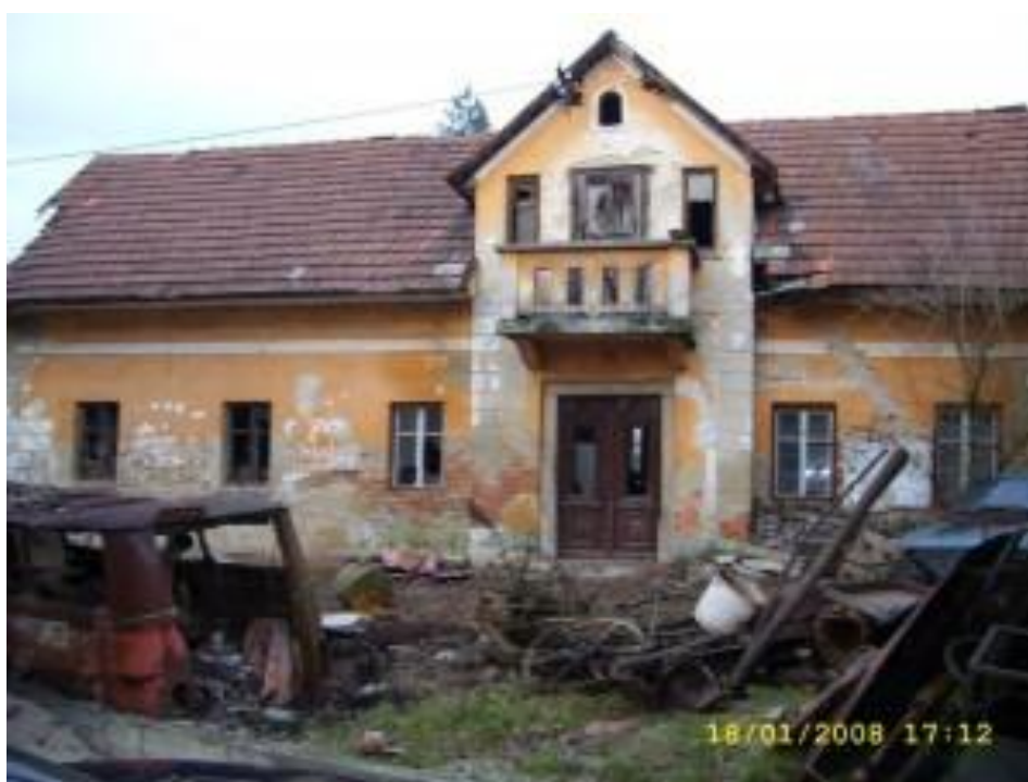
Slika 2: Obnova stare zidane hiše
