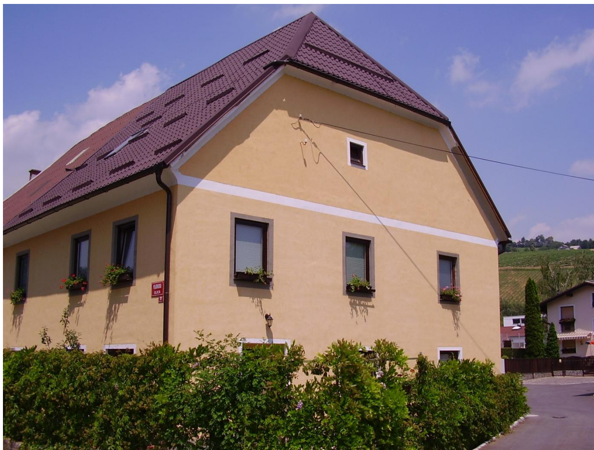
Slika 22: Hiša po prenovi
