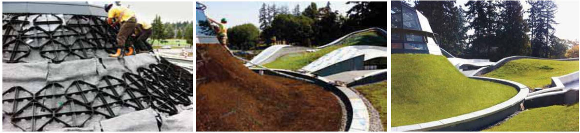
Slika 66: Preprečevanje erozije pri izdelavi poševne strehe z proti drsnimi elementi ZinCo Georaster
