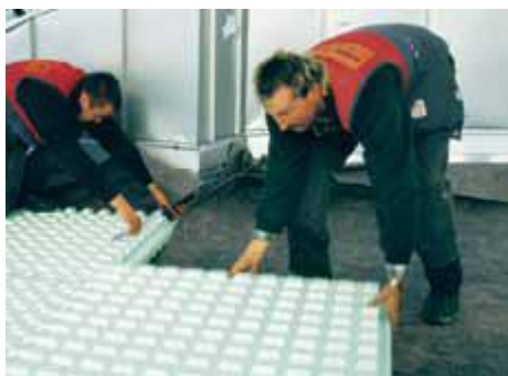
Slika 58: Polaganje vodozadrževalno drenažnih EPS plošč
