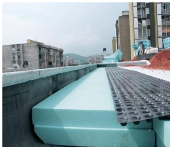
Slika 57: Prosto položena toplotna izolacija XPS na hidroizolacijo, nad njo drenažno vodozadrževalni sloj, filterski sloj, substrat.
