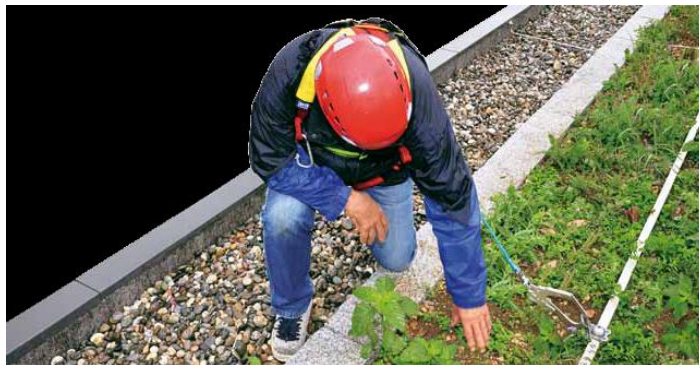
Slika 72: Vzdrževalna dela z uporabo varnostnih sredstev. Vir: http://www.zinco.de/downloads/planungshilfen_pdfs/Extensive_Dachbegrueung.pdf , 03.11.2012
