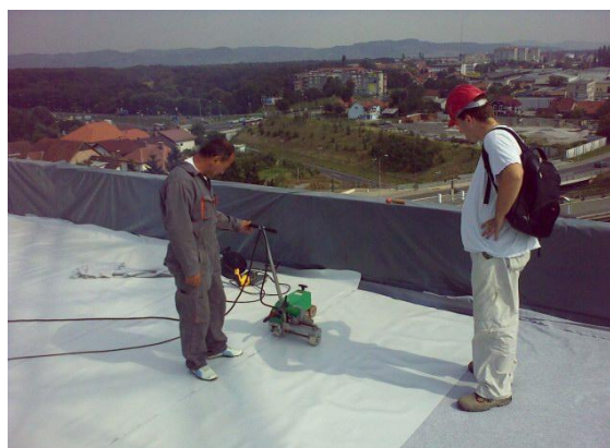
Slika 53: Varjenje polietilenske folije Vir: http://www.aurig.si/index.php?option=com_content&task=blogcategory&id=20&Itemid=118 , 26.10.2012
