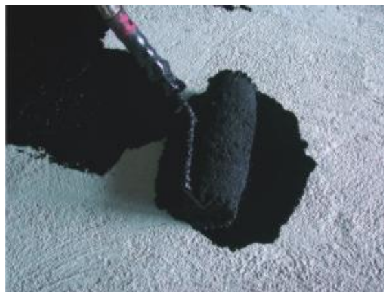
Slika 55: Ročno nanašanje bitumenskega premaza
