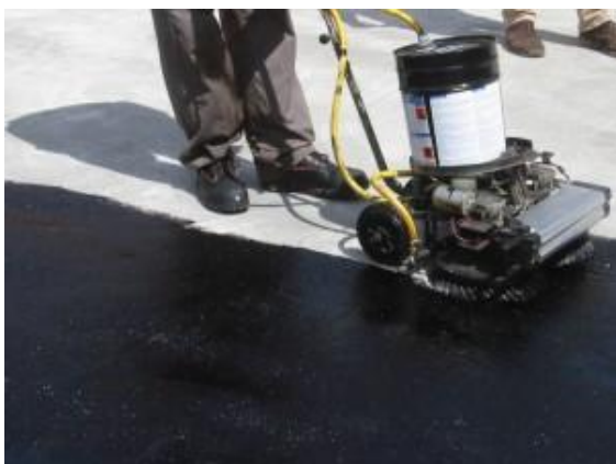
Slika 54: Strojno nanašanje bitumenskega premaza
