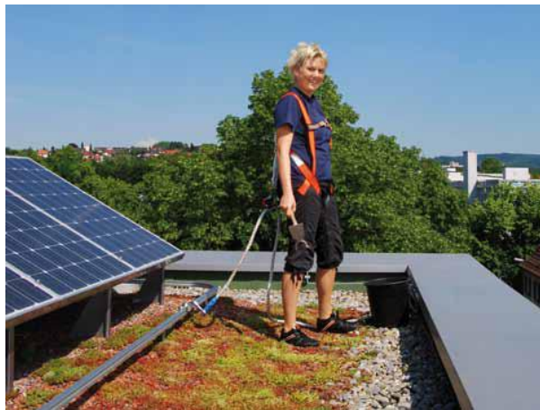
Slika 71: Zavarovanje s posebnimi varnostnimi priključki pri vzdrževalnih delih Vir: http://www.zinco.de/downloads/planungshilfen_pdfs/Extensive_Dachbegrueung.pdf , 03.11.2012
