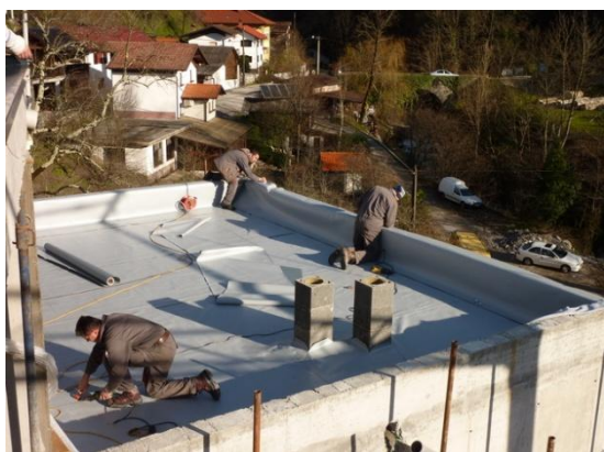
Slika 52: Polaganje hidroizolacije FATRAFOL 810 na toplotno izolacijo in atiko
