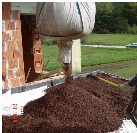
Slika 60: Transportiranje in namestitev substrata
