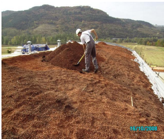
Slika 59: Namestitev substrata - objekt Geoplin Ajdovščina
