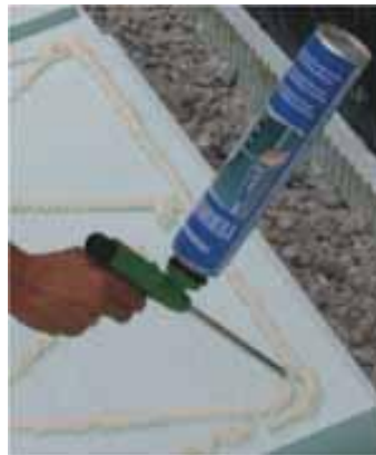
Slika 48: Lepljenje EPS plošče z poliuretanskim lepilom Vir: http://www.fragmat.si/slo/nasveti09.htm , 26.10.2012
