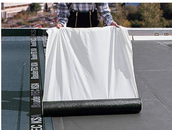
Slika 50: Nameščanje samolepilne izvedbe hidroizolacije iz bitumenskega traku Vir: http://www.bauder.si/si/ravna-streha/ravna-streha-osnove/bitumenski-trakovi/hladnosamolepilni-trakovi.html , 26.10.2012
