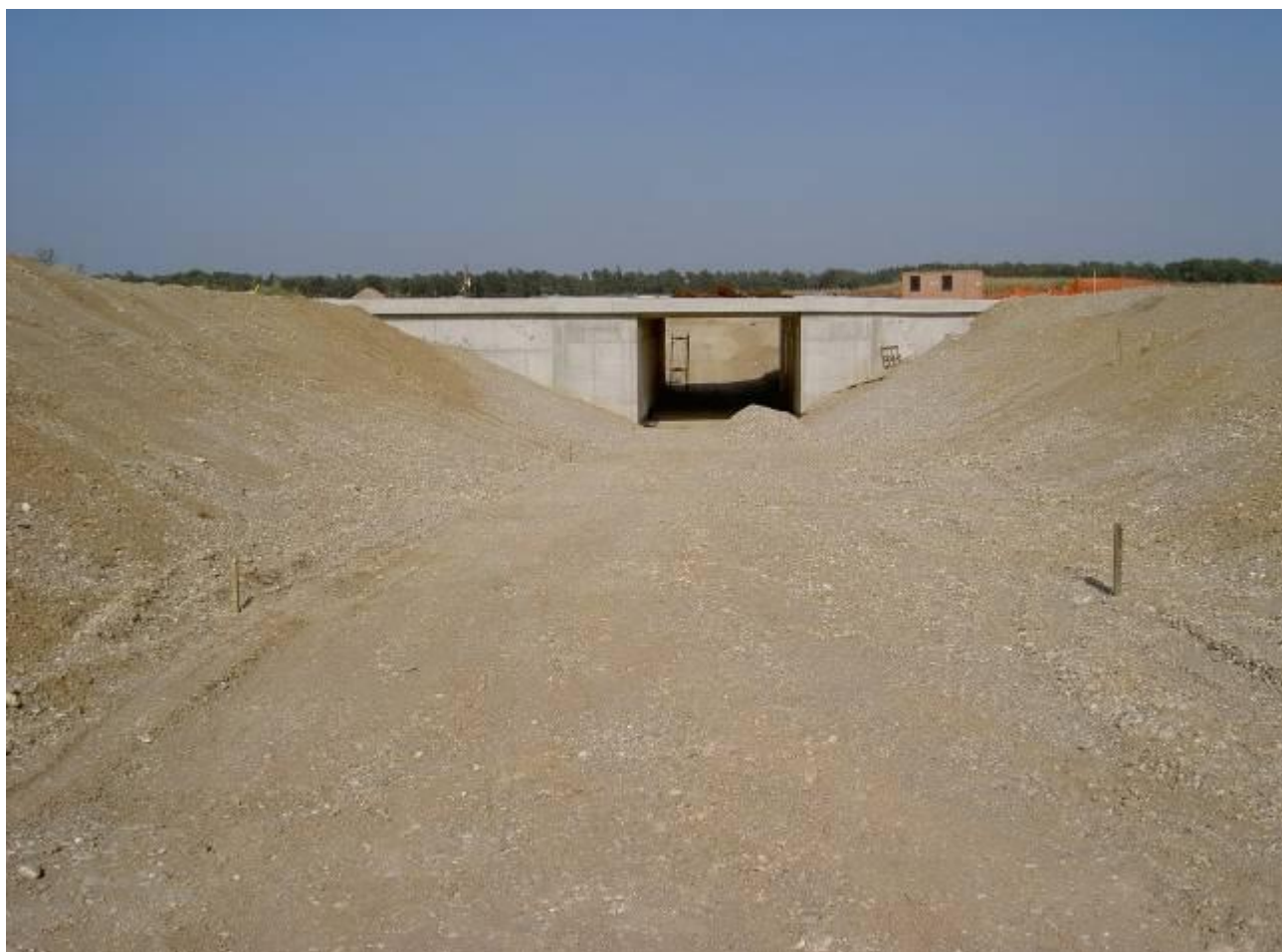
Slika 11: Urejanje brežin objekta
