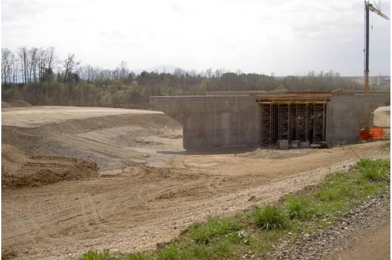
Slika 7: Izvedba sten podvoza
