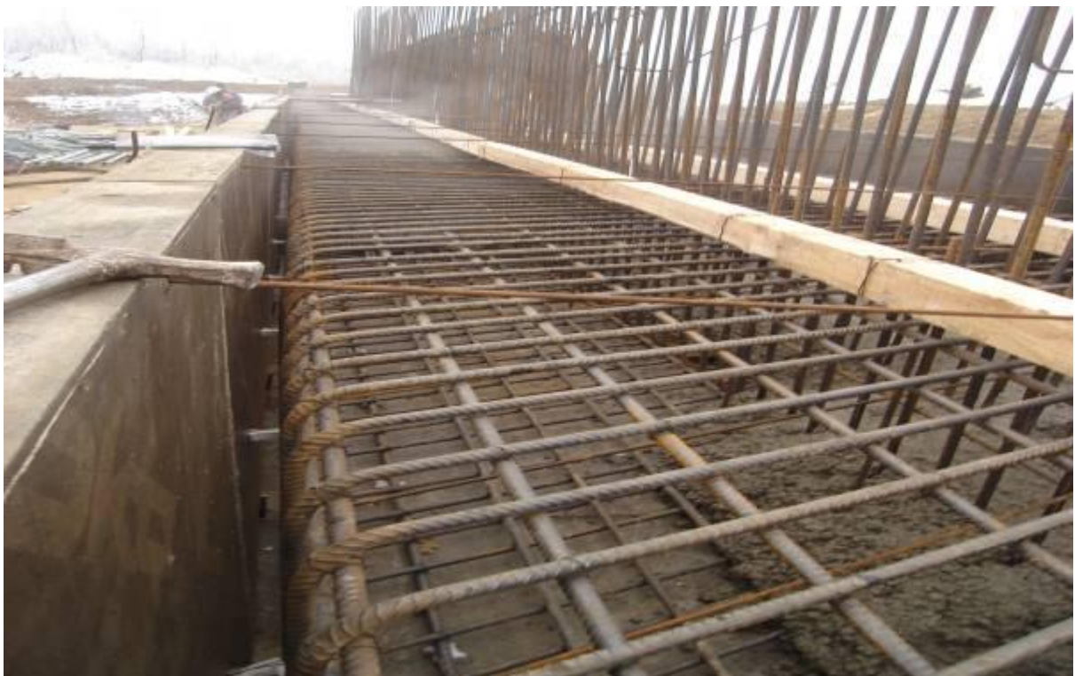
Slika 8: Polaganje armature
