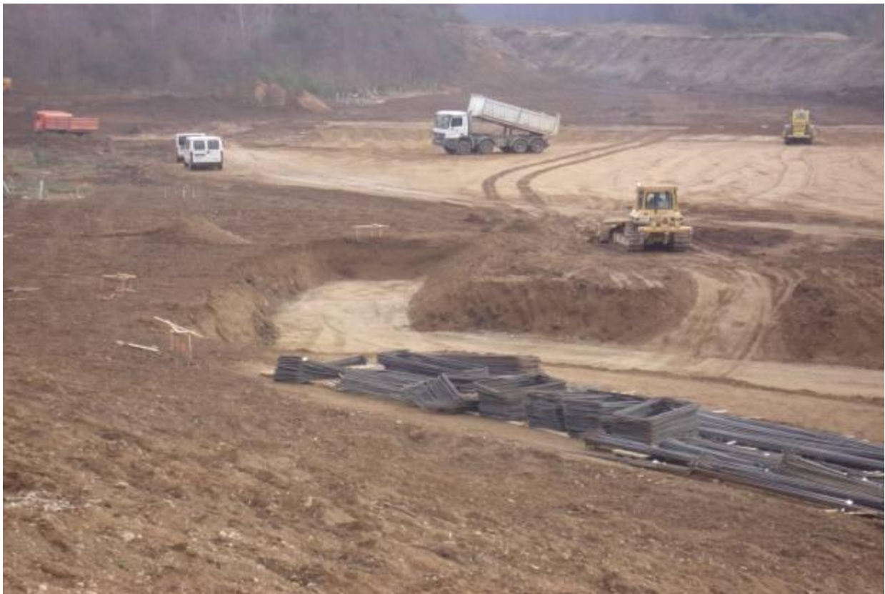
Slika 6: Priprava terena za plitvo temeljenje
