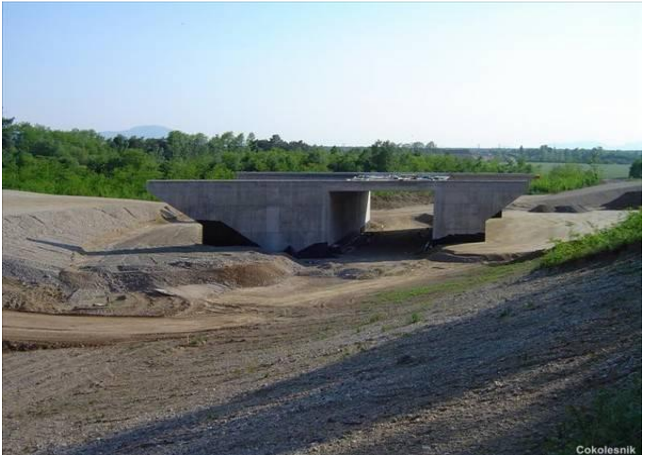
Slika 10: Zasip objekta
