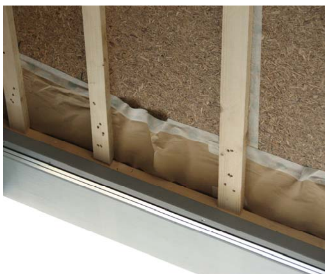
Slika 20: Slabo zalepljena folija na strešni element, kjer je uhajal zrak
