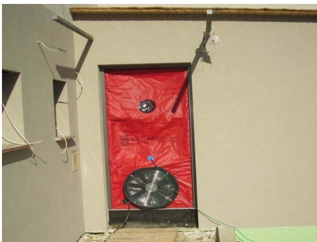
Slika 2: Ventilator z merilno napravo, ki v hiši ustvari podtlak / nadtlak, nameščen na vhodna vrata
