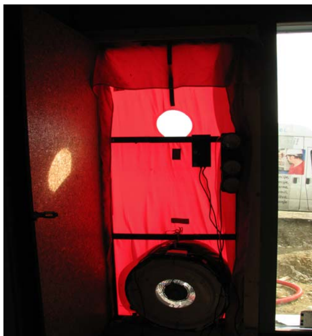
Slika 17: Vgrajena vrata s folijo, v katerih je vgrajen ventilator z merilno napravo
