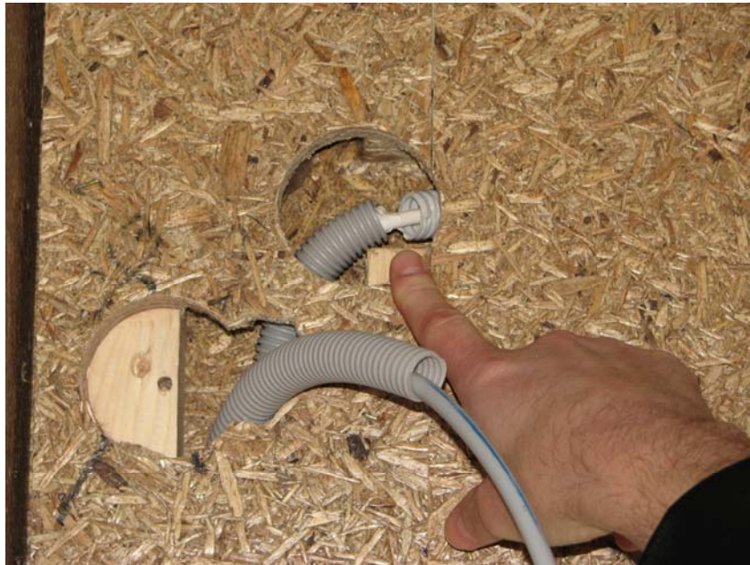
Slika 21: Uhajanje zraka skozi električne kanale, kar je bila napaka električarjev
