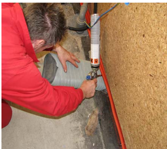
Slika 15: Tesnjenje strojno inštalacijskih prebojev z gradbeno - montažno peno
