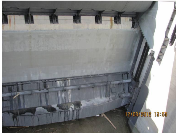
Slika 8: Spodnja zapornica HE Vuhred
