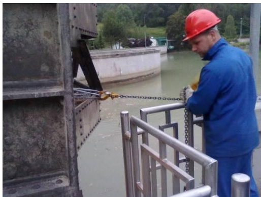
Slika 12: Vstavljanje pomožne zapornice
