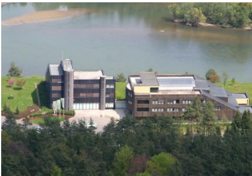
Slika 1: Dravske elektrarne Maribor, upravna stavba v Mariboru
