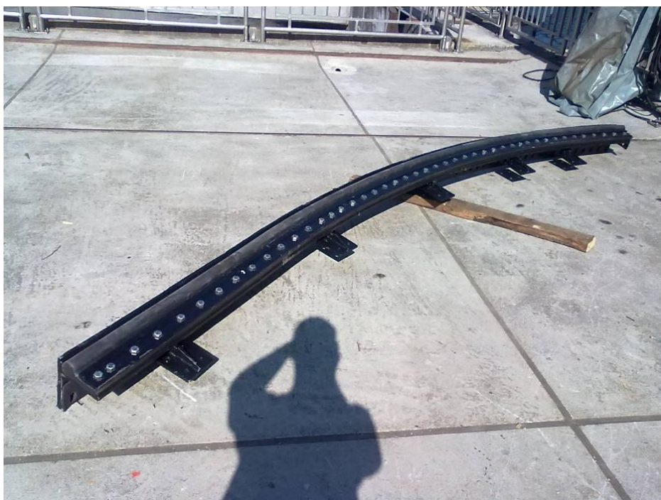
Slika 33: Bočno tesnilo pripravljeno na montažo
