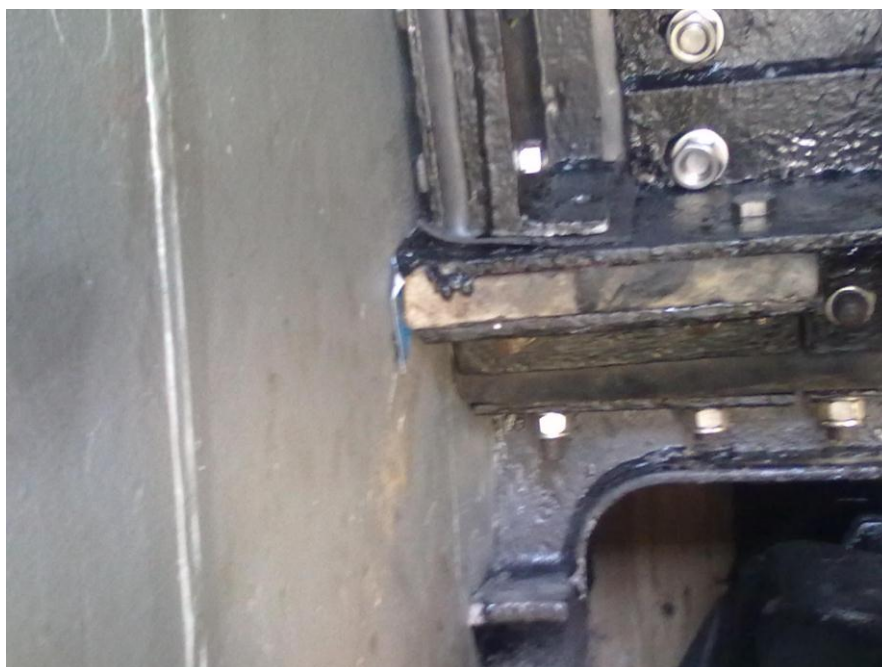
Slika 34: Vogalni stik vertikalnega tesnila
