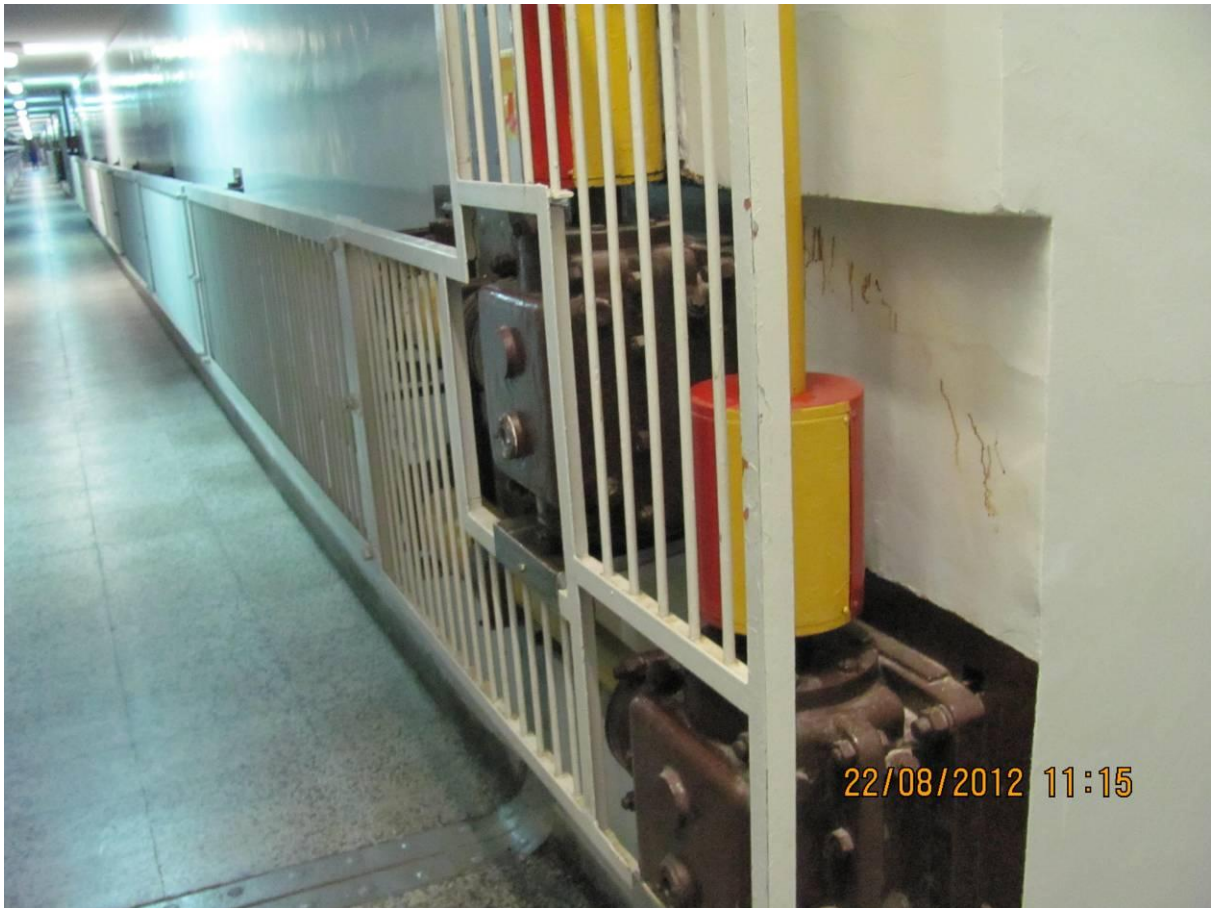
Slika 25: Horizontalne in vertikalne gredi s kotnimi prenosniki
