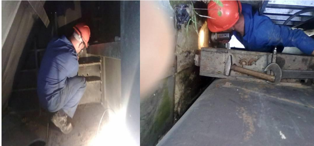
Slika 16: Demontaža protivodilnih koles
