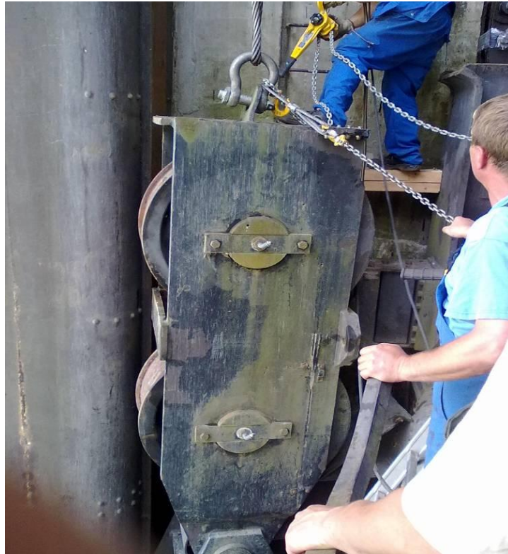
Slika 18: Demontaža vozičkov
