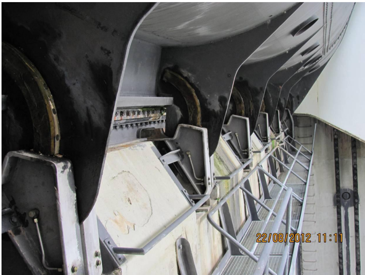
Slika 32: Drsní segmentni ležaj zaklopne zapornice
