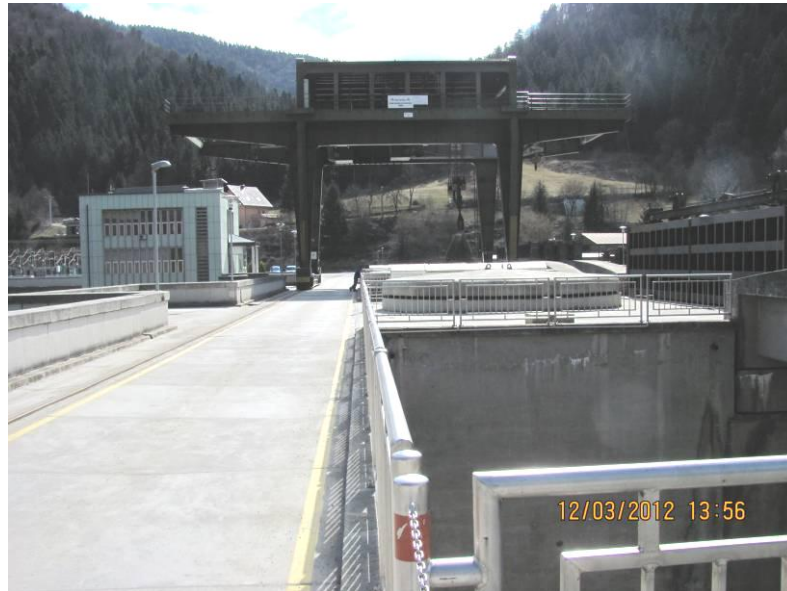
Slika 11: Slika portalnega žerjavnika in pomožnih zapornic (desno) na HE Vuhred
