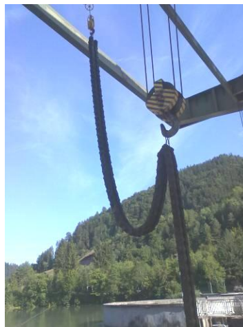
Slika 14: Demontaža z odstranjevanje Galove verige
