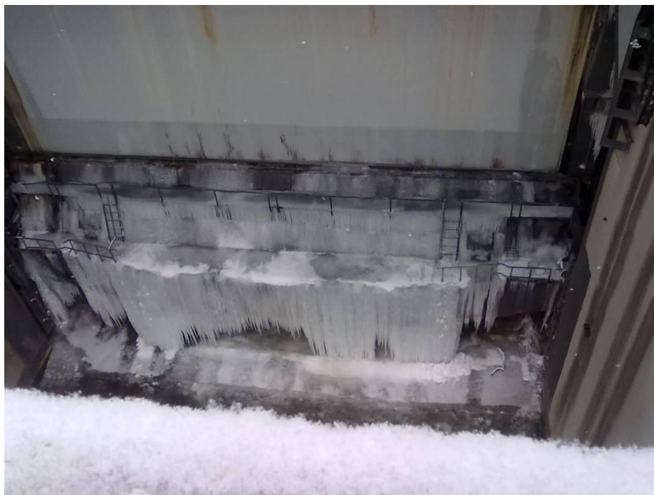
Slika 4: Poledenost kotalne zapornice (februar 2012 temp. okoli -20^{\circ}\text{C} )
