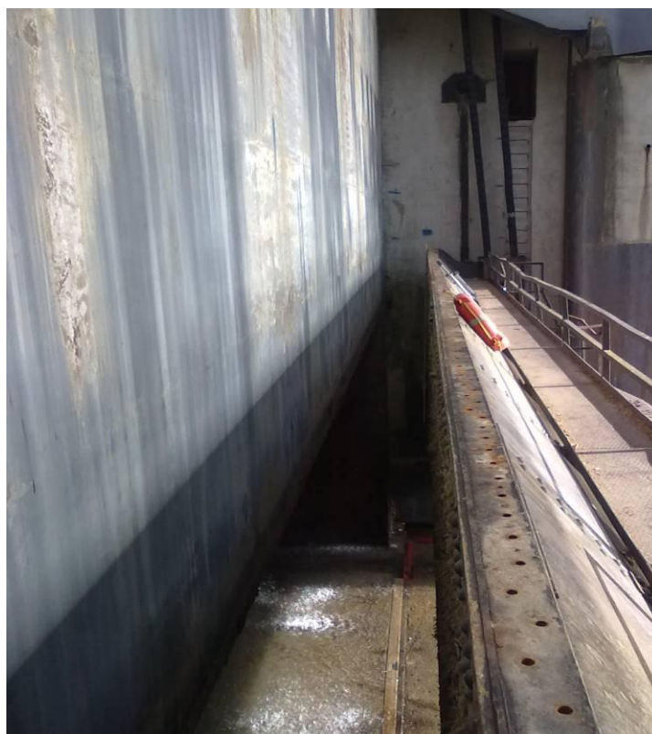
Slika 19: Odložena spodnja zapornica na stolicah
