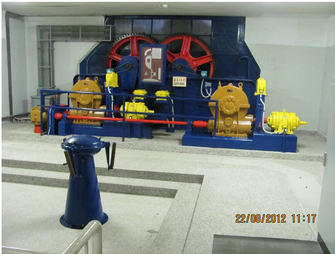
Slika 27: Primer pogonskega dela pretočnega polja
