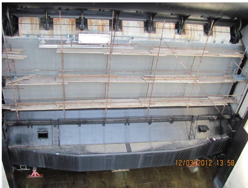
Slika 10: Slika pretočnega polja 3 na HE Vuhred (v remontu)
