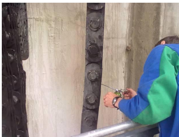
Slika 9: Vbrizgavanje penetracijskega olja med lamele Galove verige
