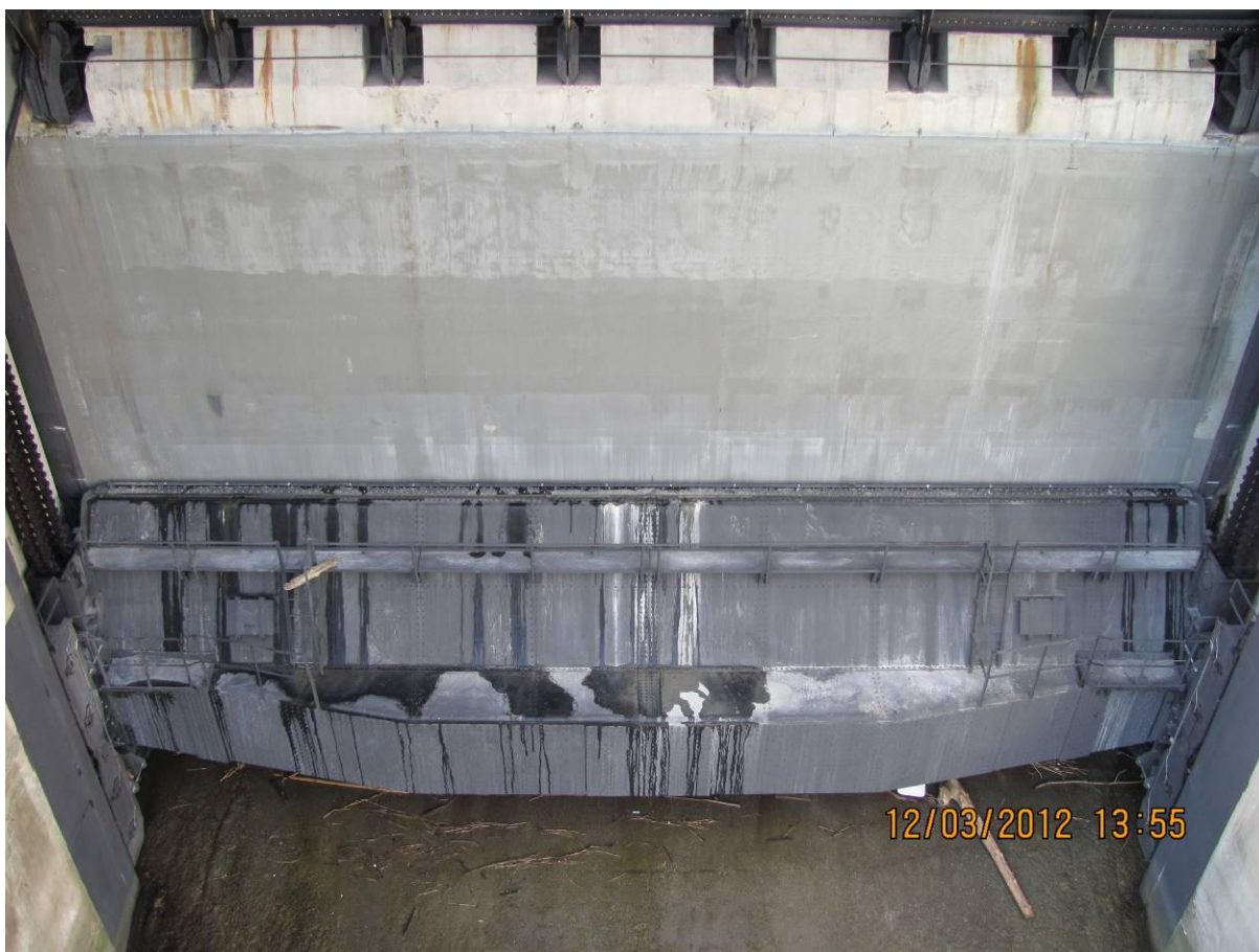
Slika 35: Pretočno polje po končanem remontu predano v obratovanje
