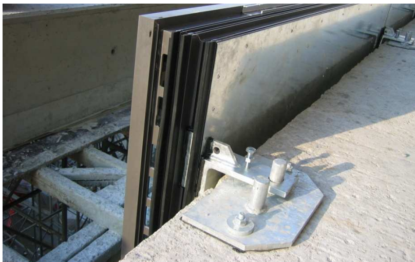
Slika 8: Primer natikanja elementne fasade na sidro
