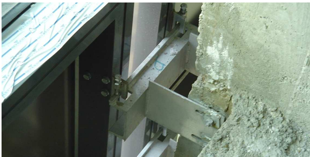
Slika 10: Prikaz vpenjanja fasade s konzolo
