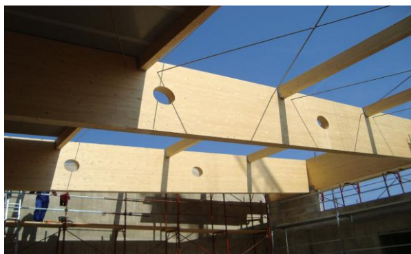
Slika 1: Prikaz lameliranega lesenega lepljenega nosilca na športni dvorani OŠ Ljudski vrt Ptuj Vir: Lasten
