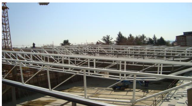
Slika 17: Primer jeklenih paličnih nosilcev na športni dvorani OŠ Ljudski vrt Ptuj
