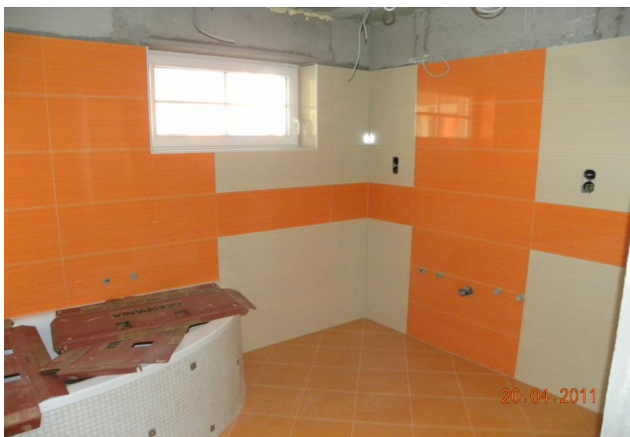
Slika 18: Položene ploščice kopalnice
