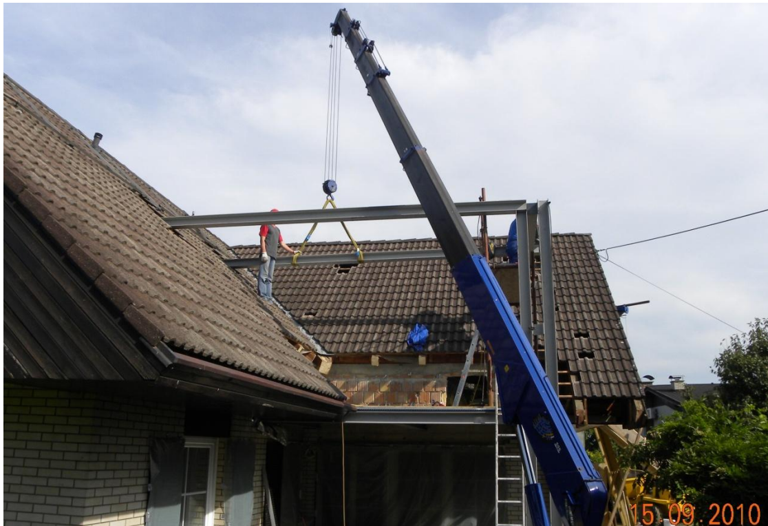
Slika 14: Montaža kovinske konstrukcije
