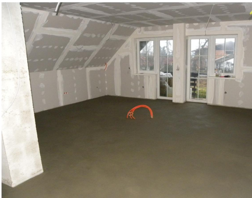
Slika 17: Izvedeni estrihi in izravnani stiki mavčnih plošč
