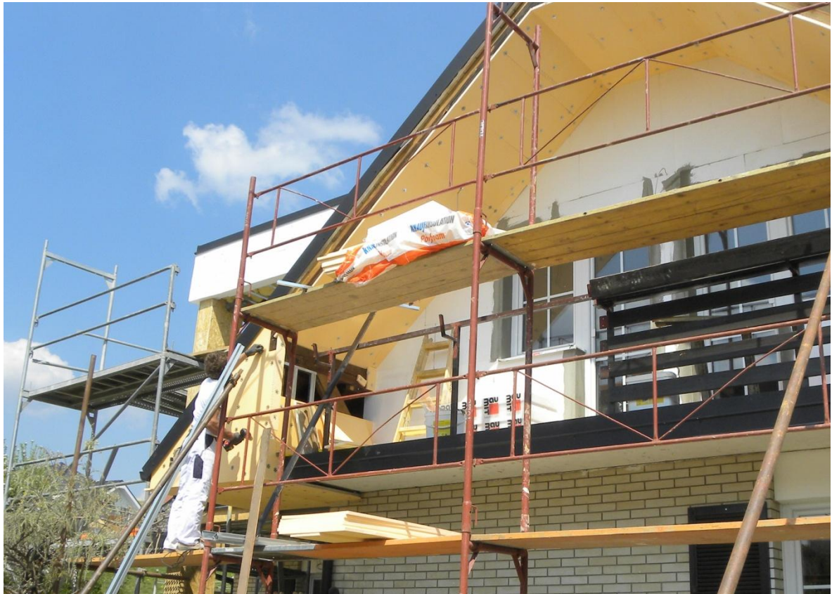
Slika 20: Izvedba Demit fasade in obdelava napuščev s stirodurjem
