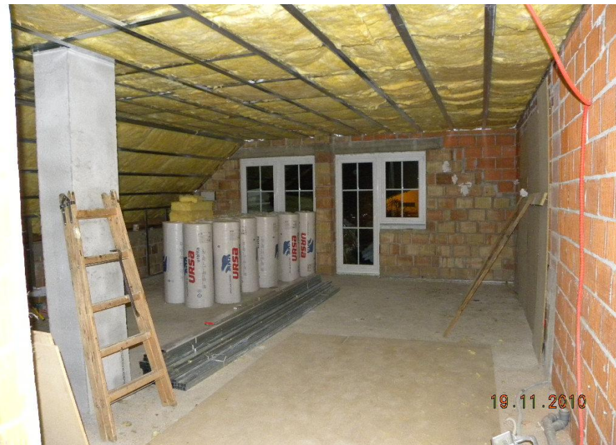
Slika 16: Pripravljena podkonstrukcija Knauf sistema
