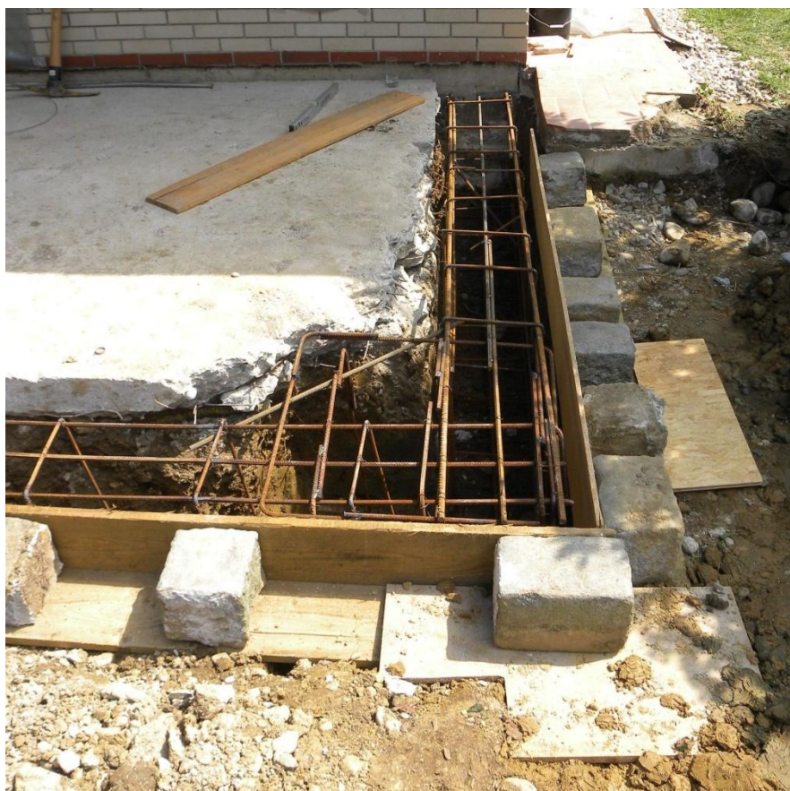
Slika 13: Armatura točkovnega temelja s temeljnima gredama
