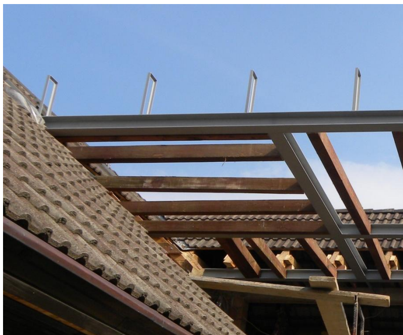
Slika 15: Lesena konstrukcija med nosilci in odrezani špirovci
