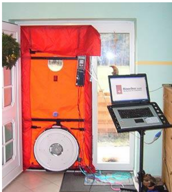
Slika 12: Blower door test membrana na vratih
