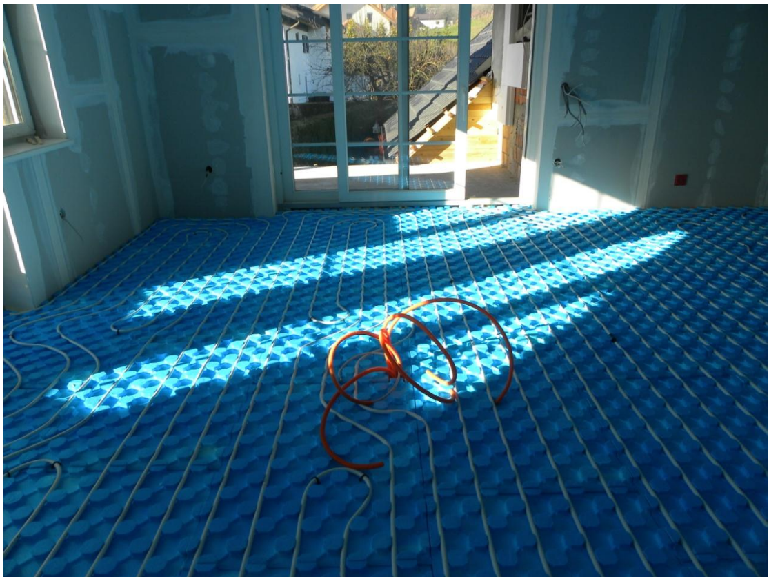
Slika 21: Cevi za talno gretje položene na plošče iz ekspandiranega polistirena
