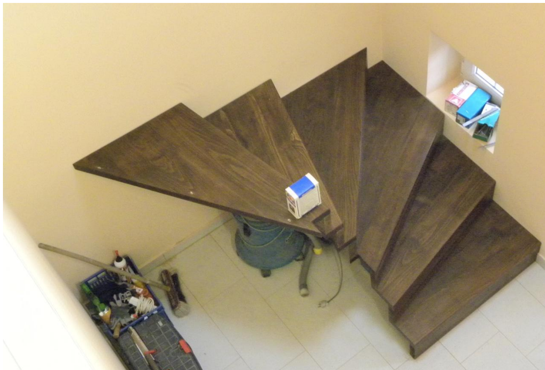
Slika 19: Montaža lesenega stopnišča
