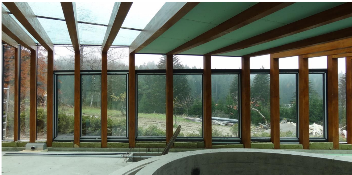
Slika 37: Slika med montažo od znotraj
