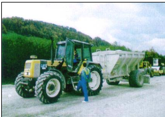
Slika 103: Posip s cementom Vir: lasten vir
