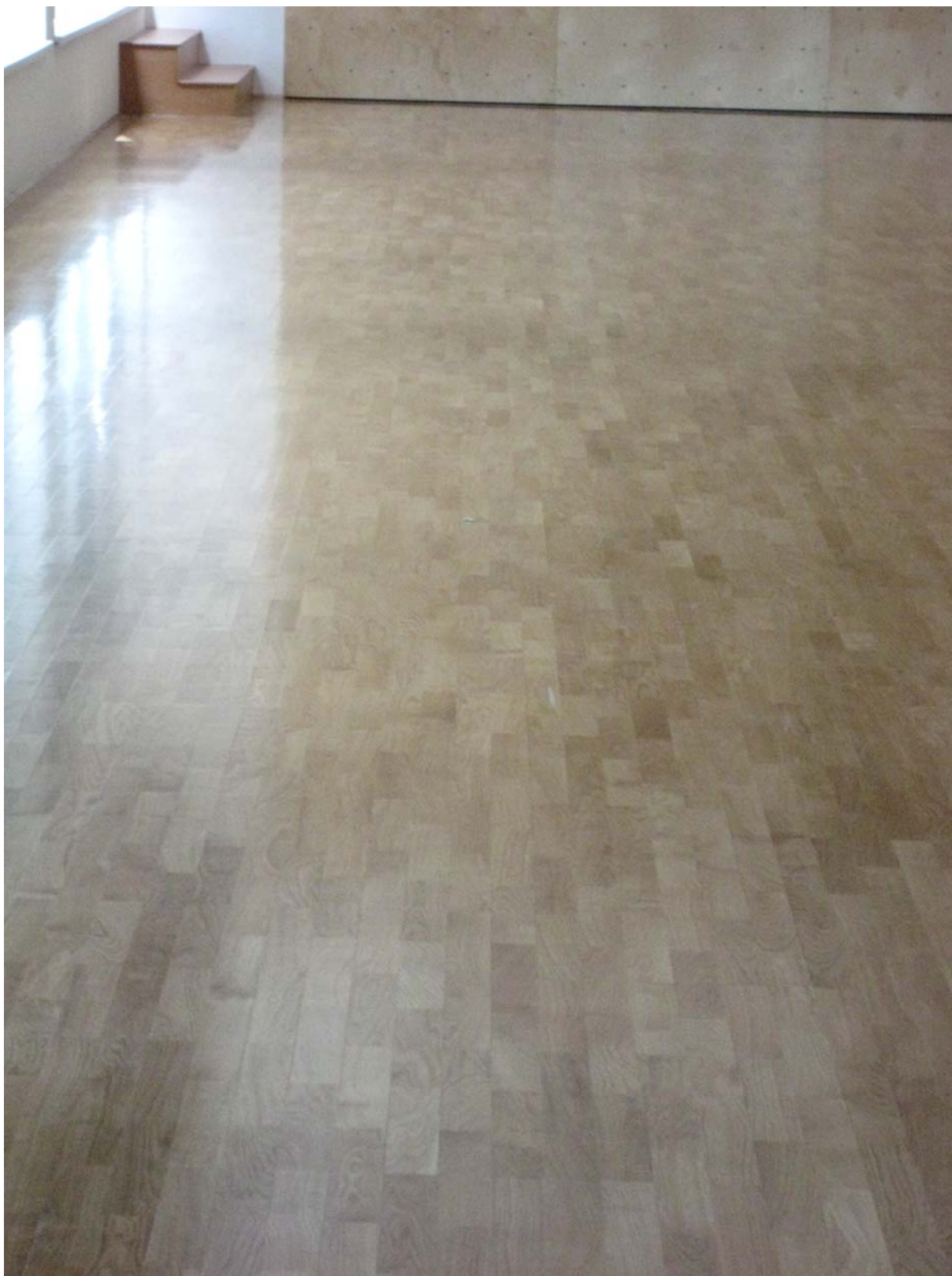
SLIKA 13: Parketna površina po opravljeni sanaciji (Štern, 2008, OŠ Dušana Bordona).
