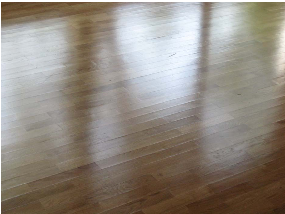
SLIKA 8: Nabrekanje parketa v nadstropju (Štern, 2008, OŠ Dušana Bordona).
