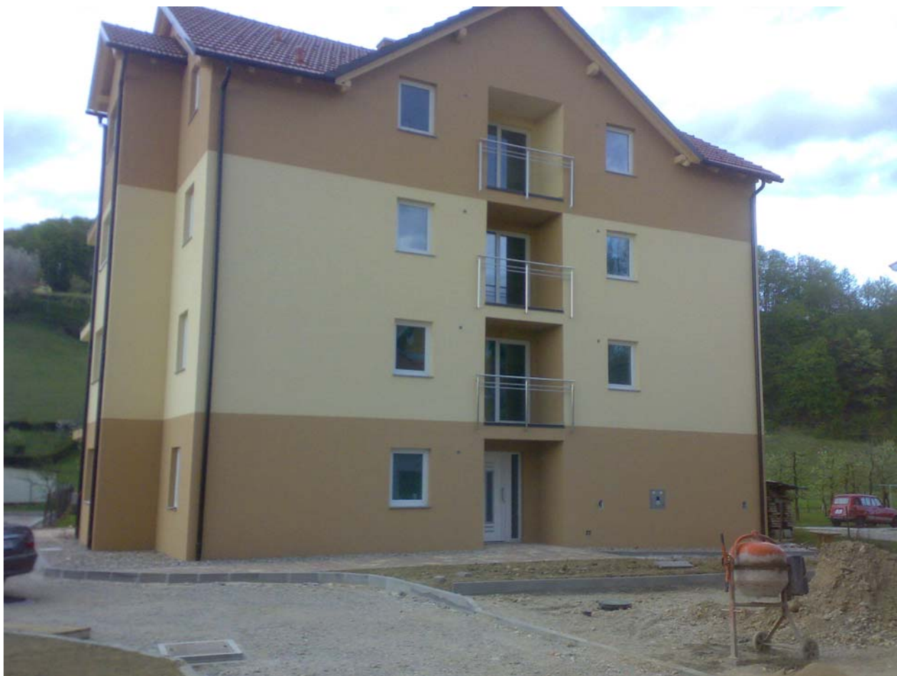
Slika 15: Prikaz sprednje strani objekta s spodnjim prikazom postavitve cestnih robnikov in predpriprave za asfalt. Vir: Lasten.
