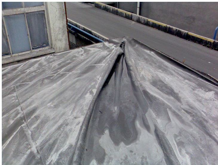
Slika 16: Sidranje je neustrezno. Folija je na kapnih mestih odstopila. Prihaja do nagubanosti folije Vir: Kovačec S., 1998
