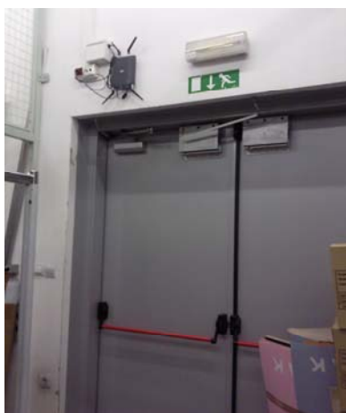
Slika 8: Prikaz postavitve anten RFID ob vhodu v skladišče. Vir: lasten.
