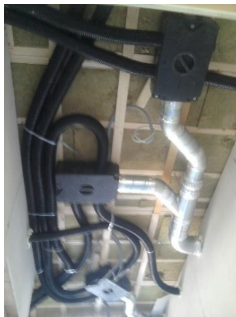
Slika 16: Namestitev stropnih vodov prezračevalnega sistema
