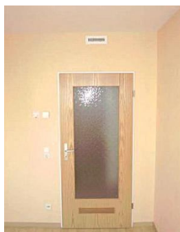
Slika 17: Odvod zraka skozi reže v vratih
