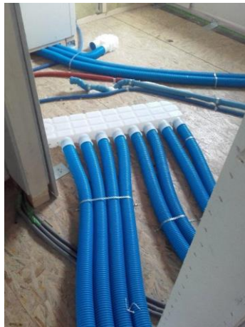
Slika 15: Namestitev talnih vodov prezračevalnega sistema
