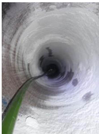
Slika 5: Primer suhega čiščenja z rotacijsko krtačo
