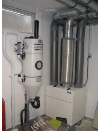
Slika 14: Kurilnica, kjer je nameščena prezračevalna naprava
