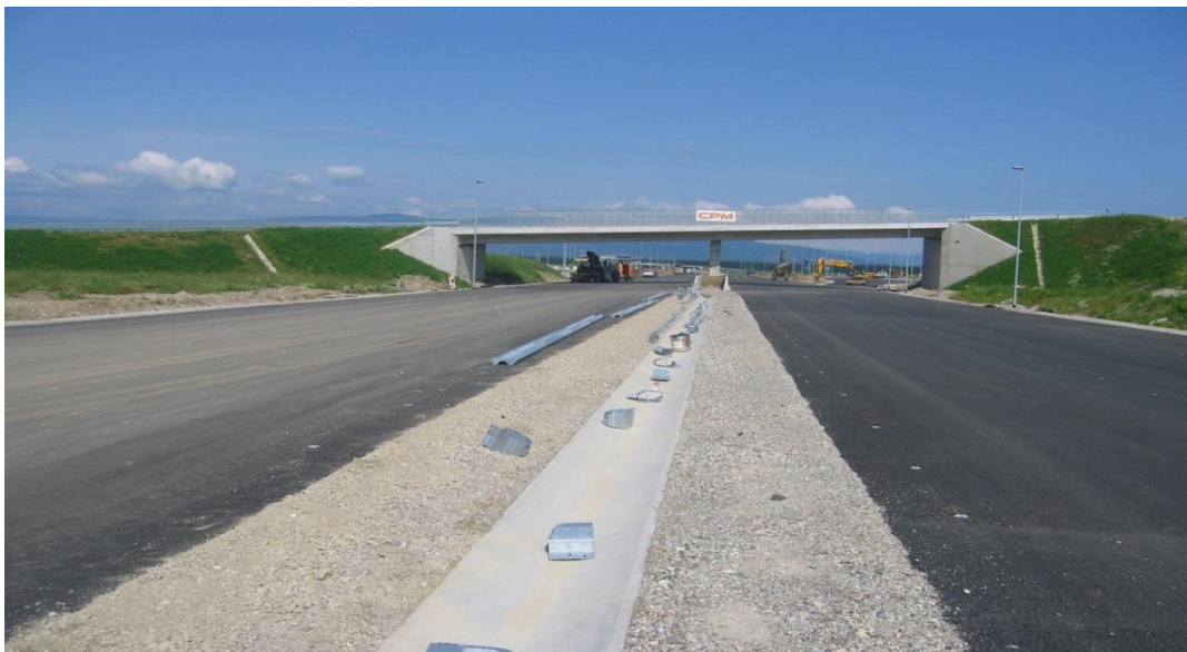
Slika 20: Izvedba zaščitne ograje
