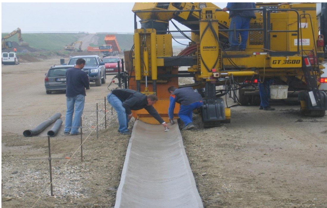
Slika 18: Izvedba mulde s trimerjem
