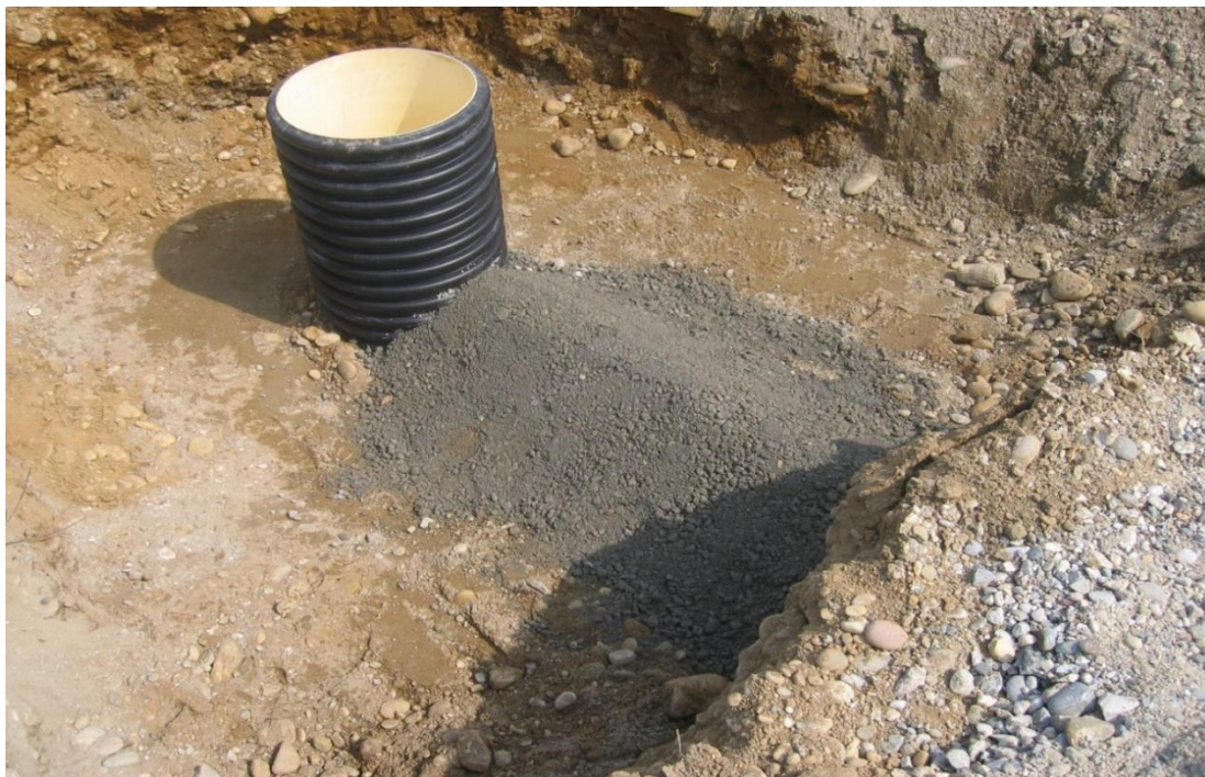
Slika 12: Vgradnja požiralnika
