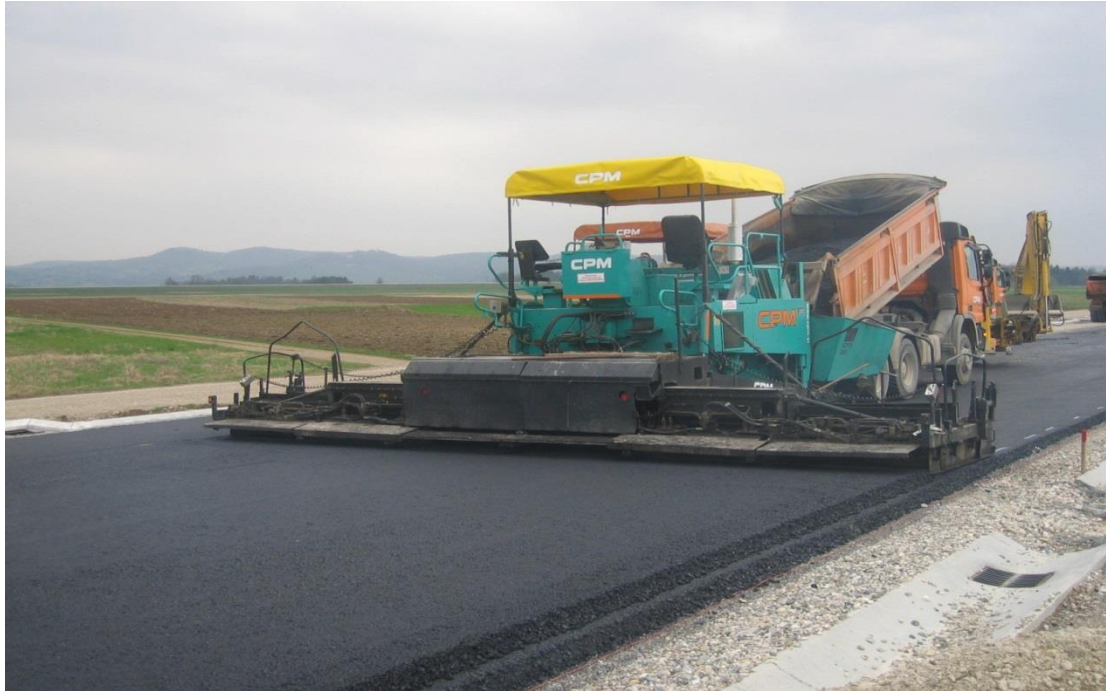
Slika 19: Izvedba obrabne plasti
