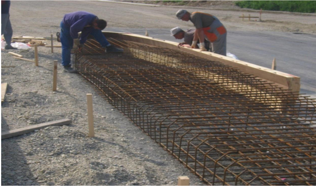
Slika 21: Priprave pred betonažo
