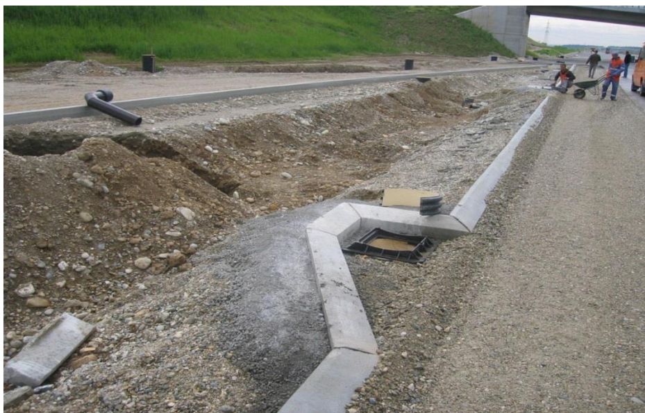
Slika 10: Požiralniki pred asfaltiranjem
