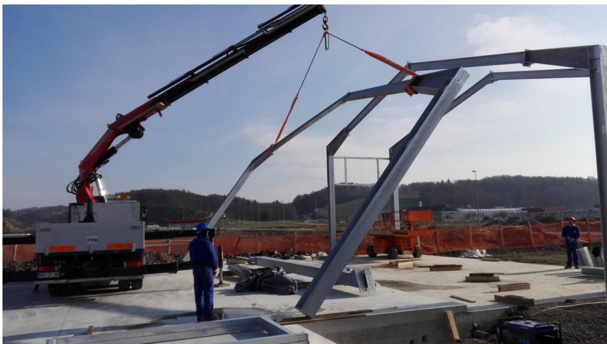
Slika 22: Postavitev okvirja konstrukcije
