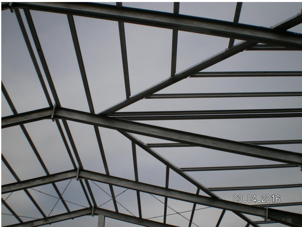
Slika 24: Žlota, vijačena s SFS vijaki Vir: (Projektiranje Alja, David Urbanič s.p., 2016)
