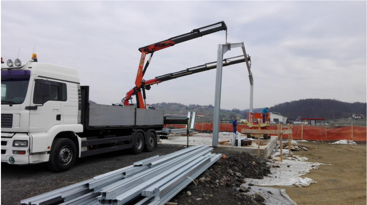
Slika 20: Postavitev prvega okvirja konstrukcije
