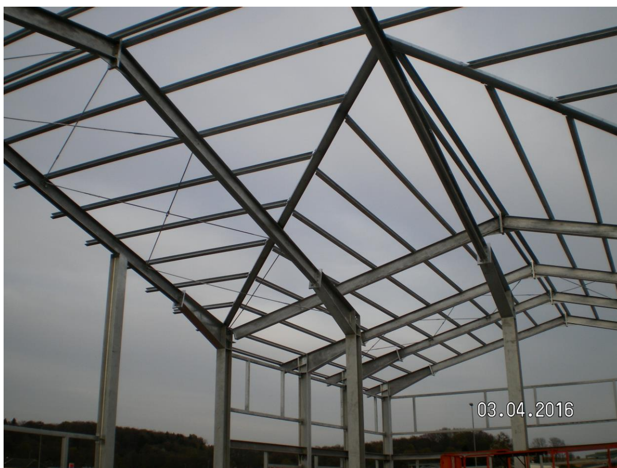
Slika 27: Vidne zatege na strehi iz paličnega jekla premera 30 mm
