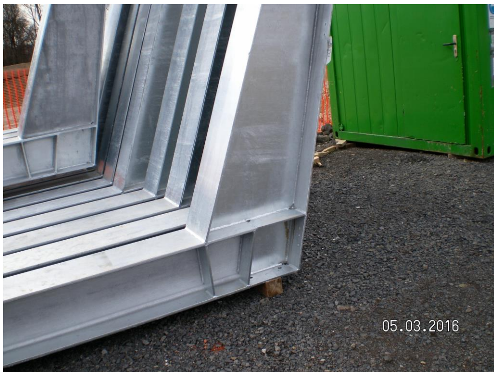
Slika 18: primer, pocinkani stebri konstrukcije na gradbišču Lar
