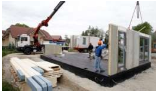
Slika 16: Montaža hiše na gradbišču
