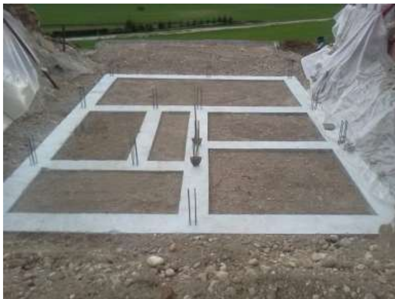
Slika 5: Postavitev temeljev pri klasični gradnji
