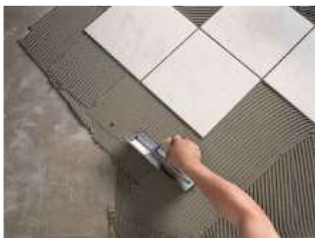
Slika 18: Polaganje ploščic
