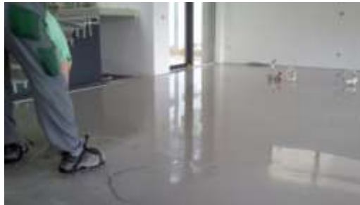
Slika 8: Izdelava betonskih tlakov
