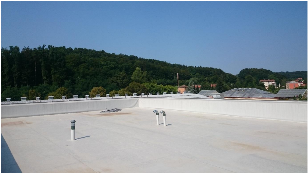
Slika 8: Klasična ravna streha prekrita z siko
