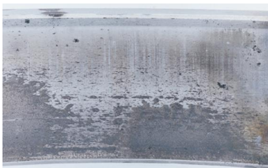
Slika 27: Površinsko luščenje
