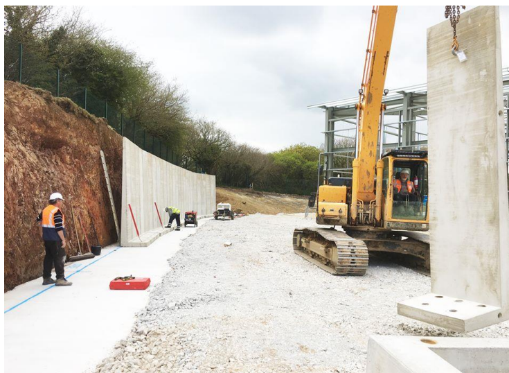
Slika 1: Primer offsite gradnje opornega zidu
