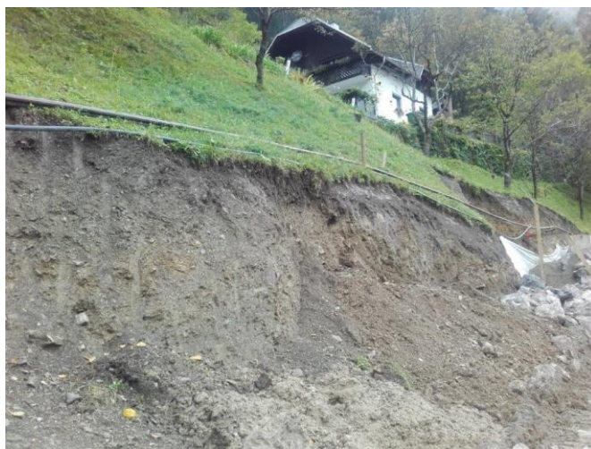
Slika 12: Porušitev in odstranitev obstoječega zidu iz cementnega betona
