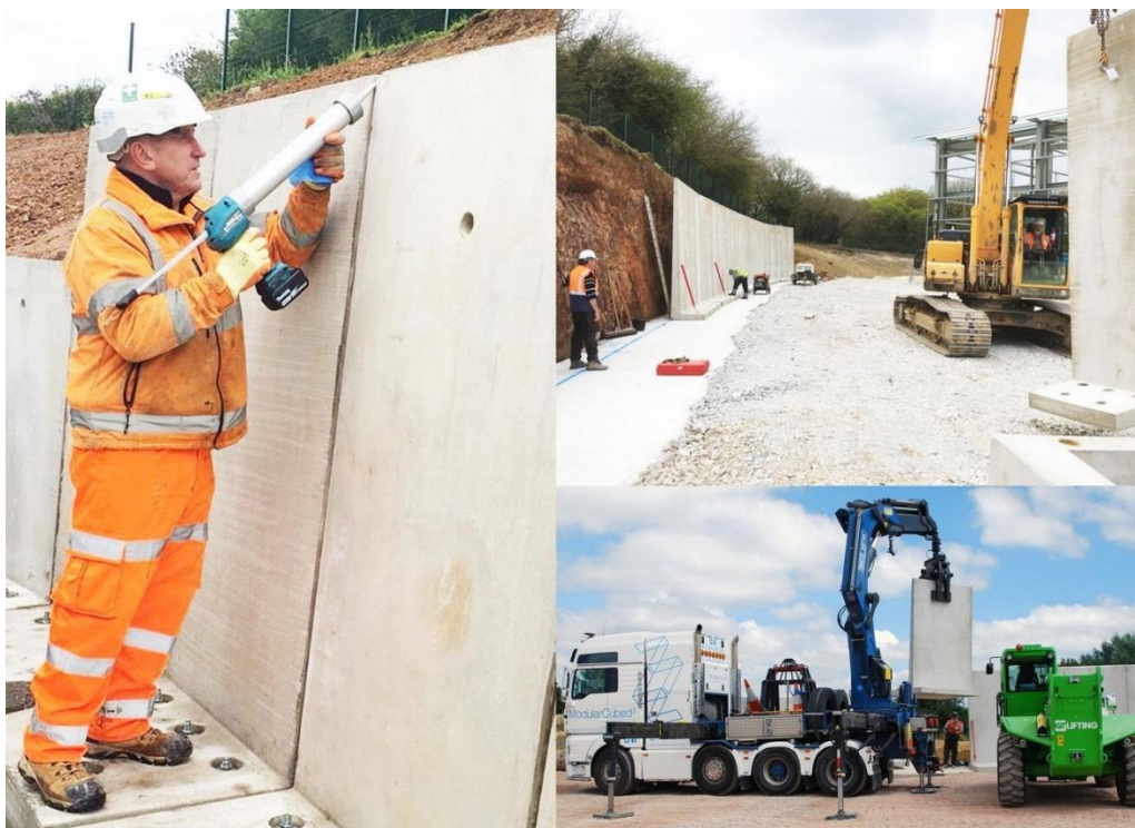
Slika 23: Prikaz namestitve prefabriciranih elementov opornega zidu podjetja JP Concrete
