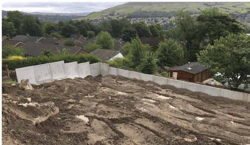
Slika 19: Prefabricirani oporni zid podjetja JP Concrete
