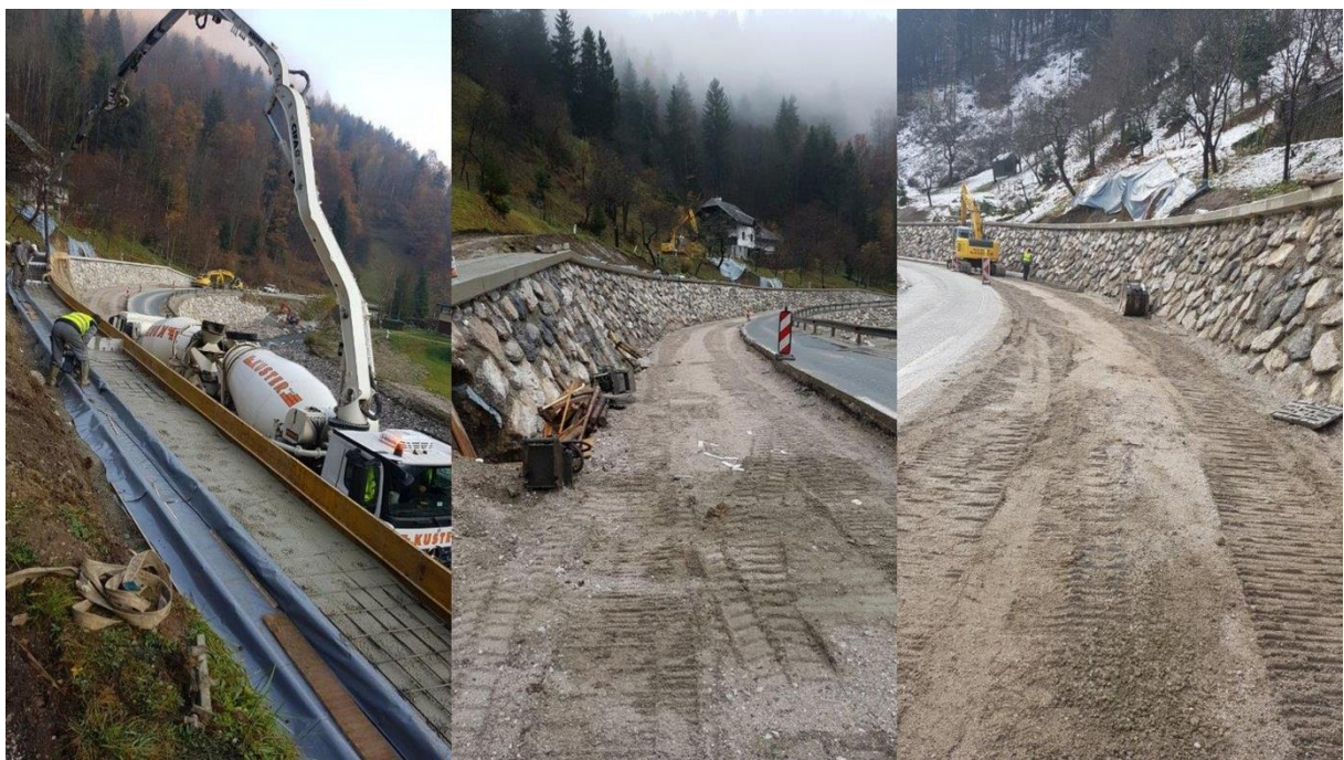
Slika 15: Prikaz izgradnje opornega zidu podjetja KUSTER d. o. o.
