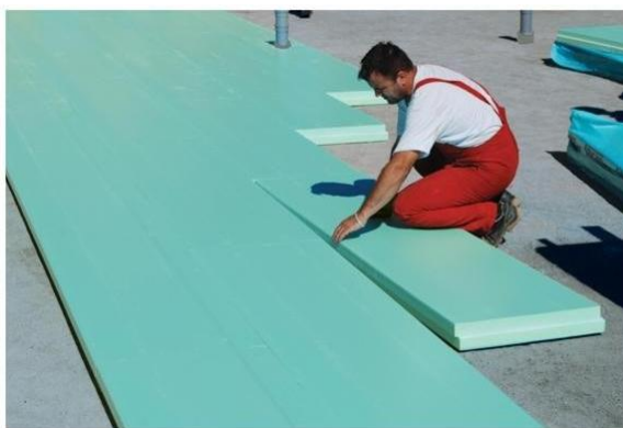
Slika 5: Prikaz načina polaganja XPS plošč
