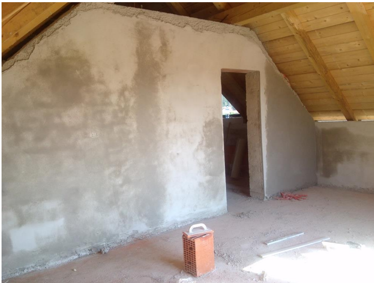
Slika 1: Notranji apneni omet
