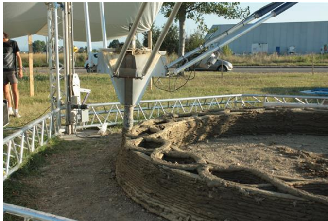
Slika 20: Tiskalnik Big Delta 3D tiska z mešanico blata in slame
