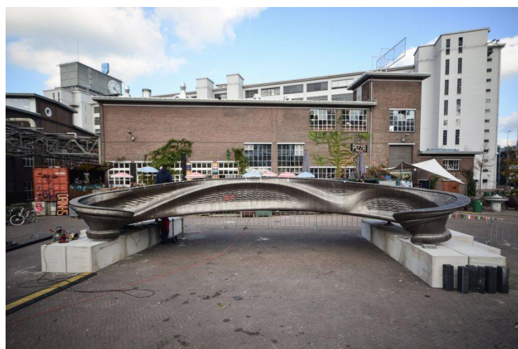
Slika 11: Jeklen most v Amsterdamu, ki je bil natisnjen s tehnologijo varjenja.
