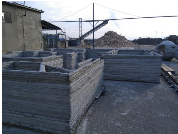
Slika 25: Primer tiskanja sten s tiskalnikom BetAbram P1
