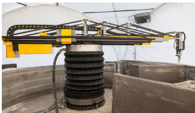
Slika 19: Apis Cor med tiskanjem vzorčne hiše
