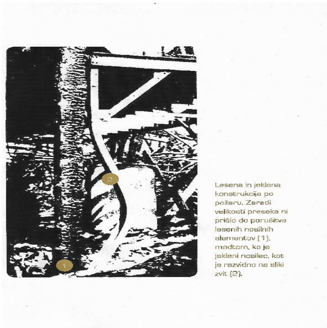
Slika 1: Lesena in jeklena konstrukcija po požaru
