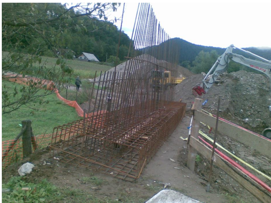
Slika 17: Zvezan temelj na delovnem platoju nad gradbeno jamo
