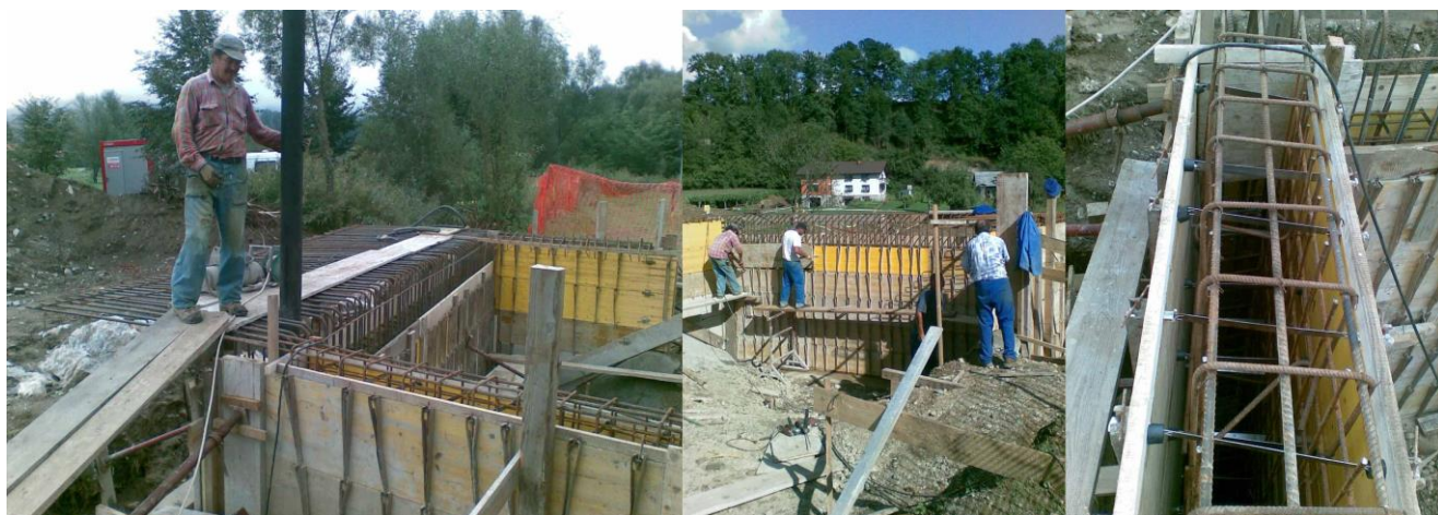
Slika 20: Opaž ter armatura opornikov in kril
