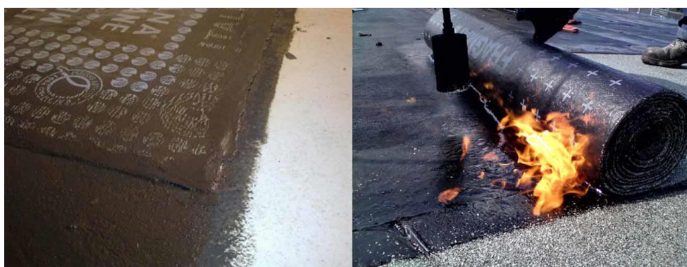
Slika 23: Simbolična slika varjenje hidroizolacije
