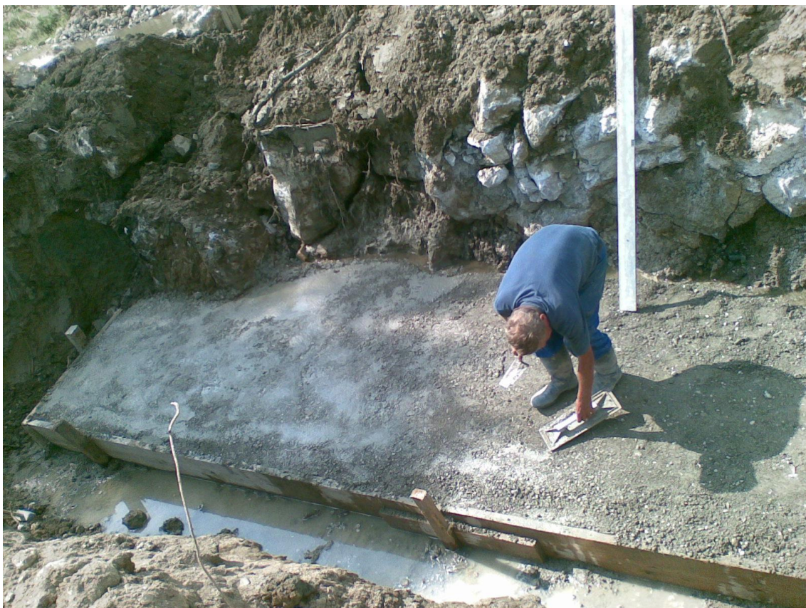
Slika 14: Izdelava pustega betona
