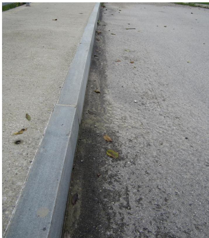
Slika 24: Granitni robniki mostu
