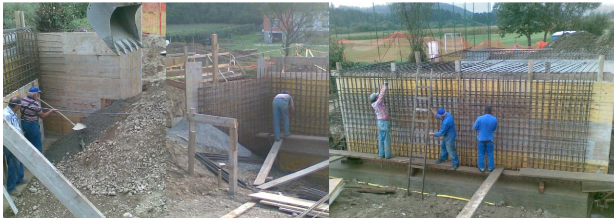
Slika 18: Izdelava opornika ter kril
