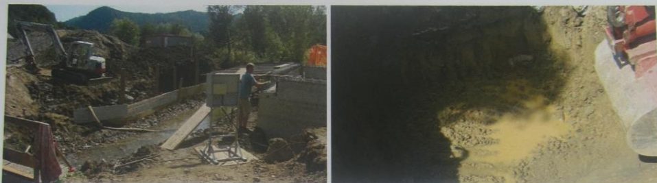
Slika: Most v fazi izgradnje (levo) in izkopi za pasovne temelje opornika 1 (desno).
