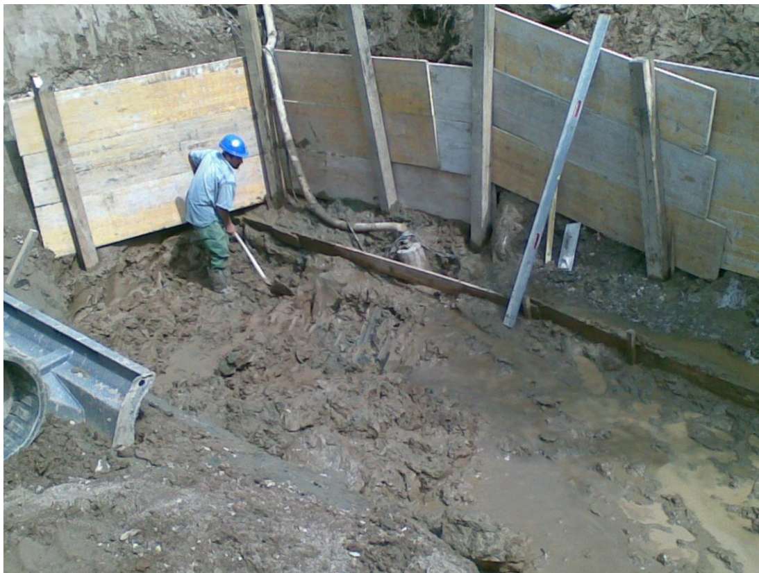
Slika 13: zaščita gradbene jame
