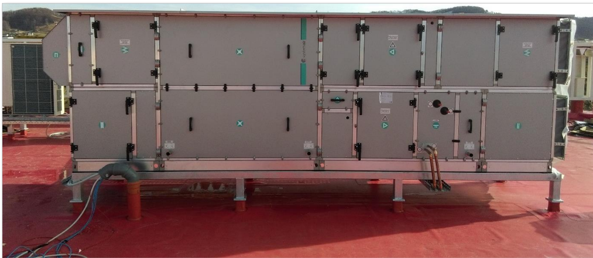
Slika 4: Primer klimatske naprave izvedbe HSO
