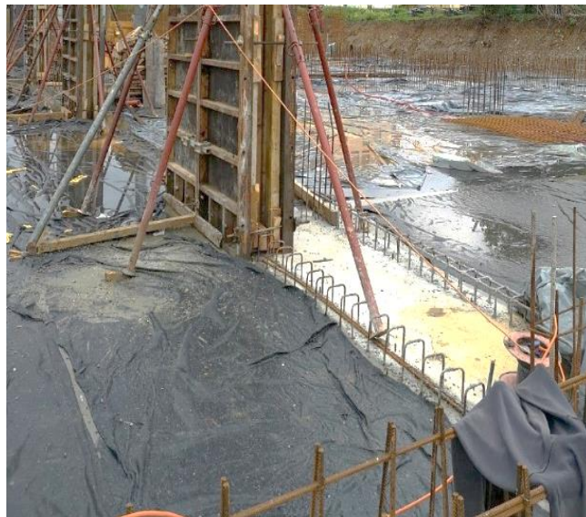
Slika 2: Izvajanje nege betona na AB temeljni plošči
