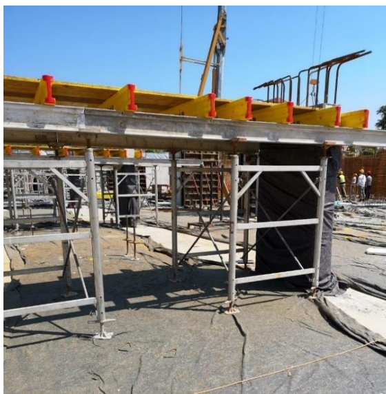
Slika 3: Izvajanje nege betona na AB temeljnih stebrih
