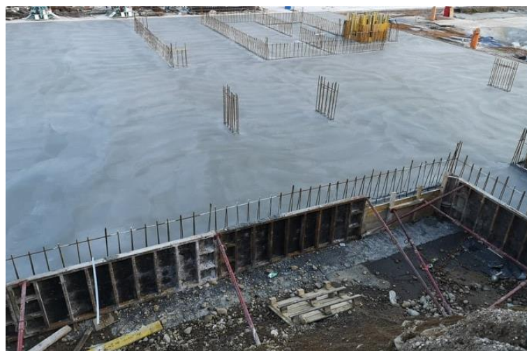
Slika 10: AB temeljna plošča kleti
