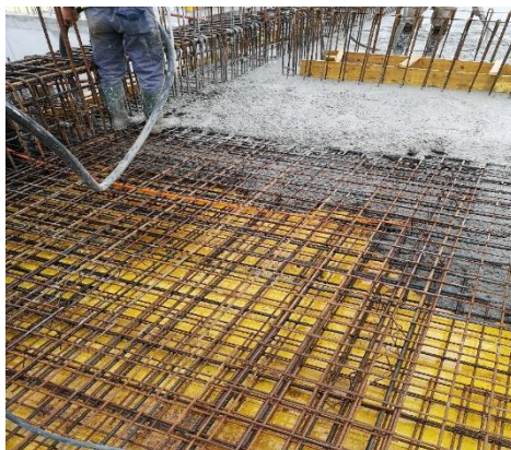
Slika 6: Vibriranje medetažne plošče
