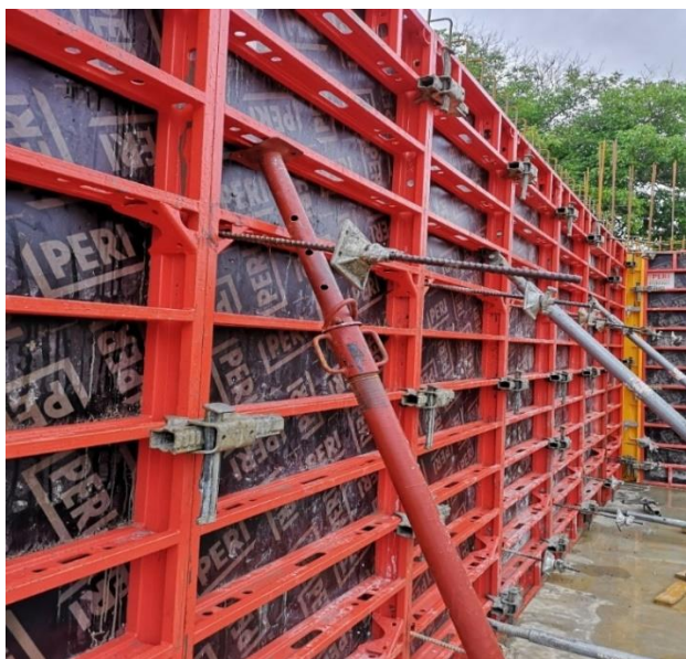
Slika 7: Postavitev opaža na AB steno večstanovanjskega objekta
