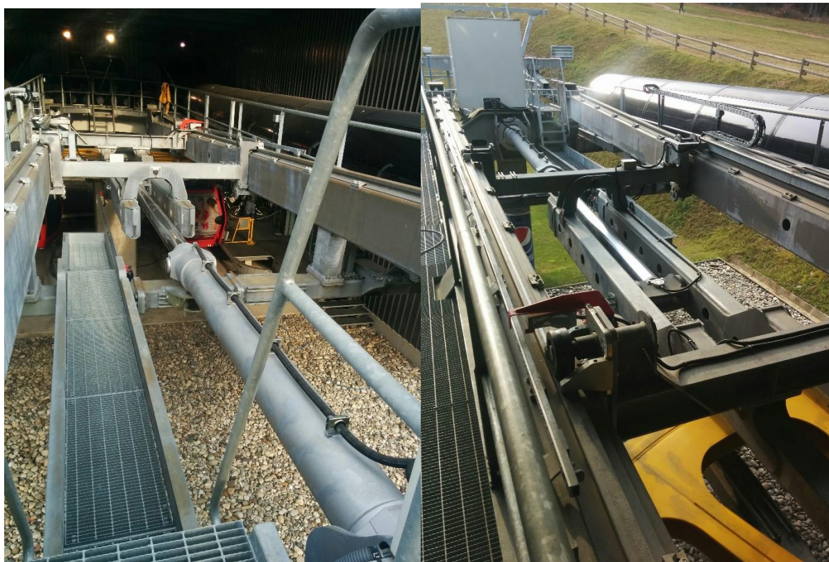
Slika 9: Napenjalni cilinder na spodnji postaji
