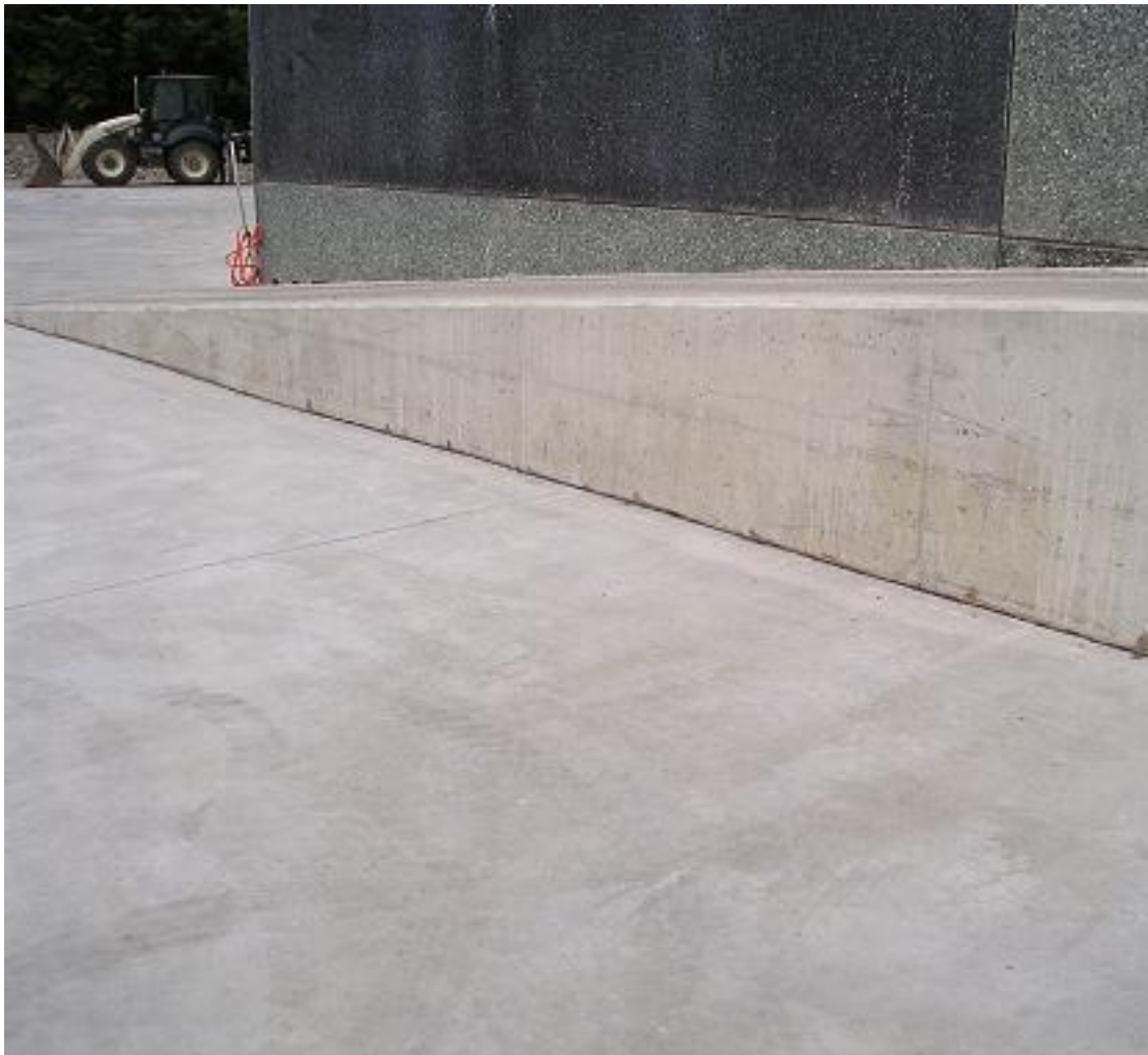
Slika 14: Betonska plošča za prevoz
