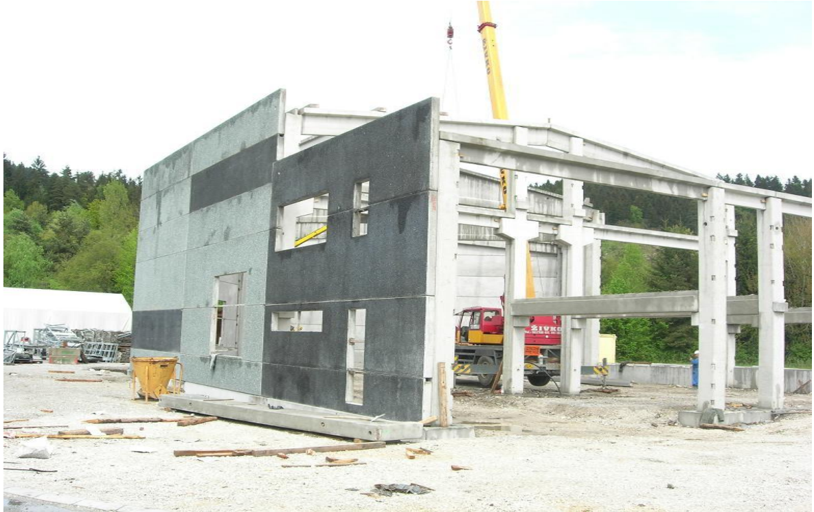
Slika 9: Montažna betonska konstrukcija
