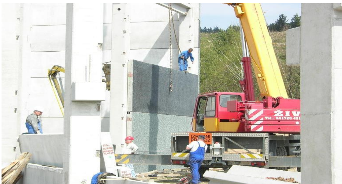
Slika 8: Montažna betonska konstrukcija
