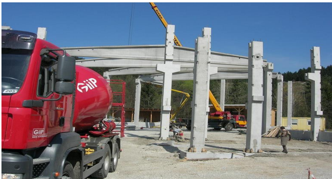
Slika 7: Montažna betonska konstrukcija
