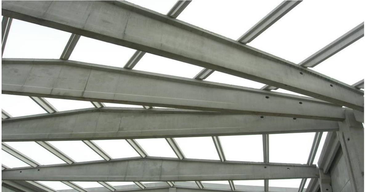
Slika 10: Armiranobetonska strešna konstrukcija
