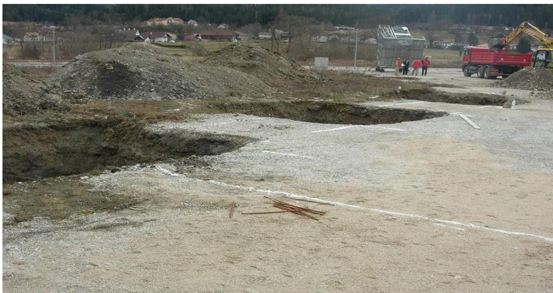
Slika 5: Izkop za točkovne temelje
