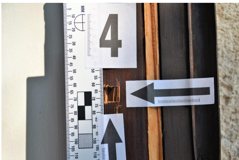
Slika 5: Sled vlomilskega orodja na okvirju vrat
