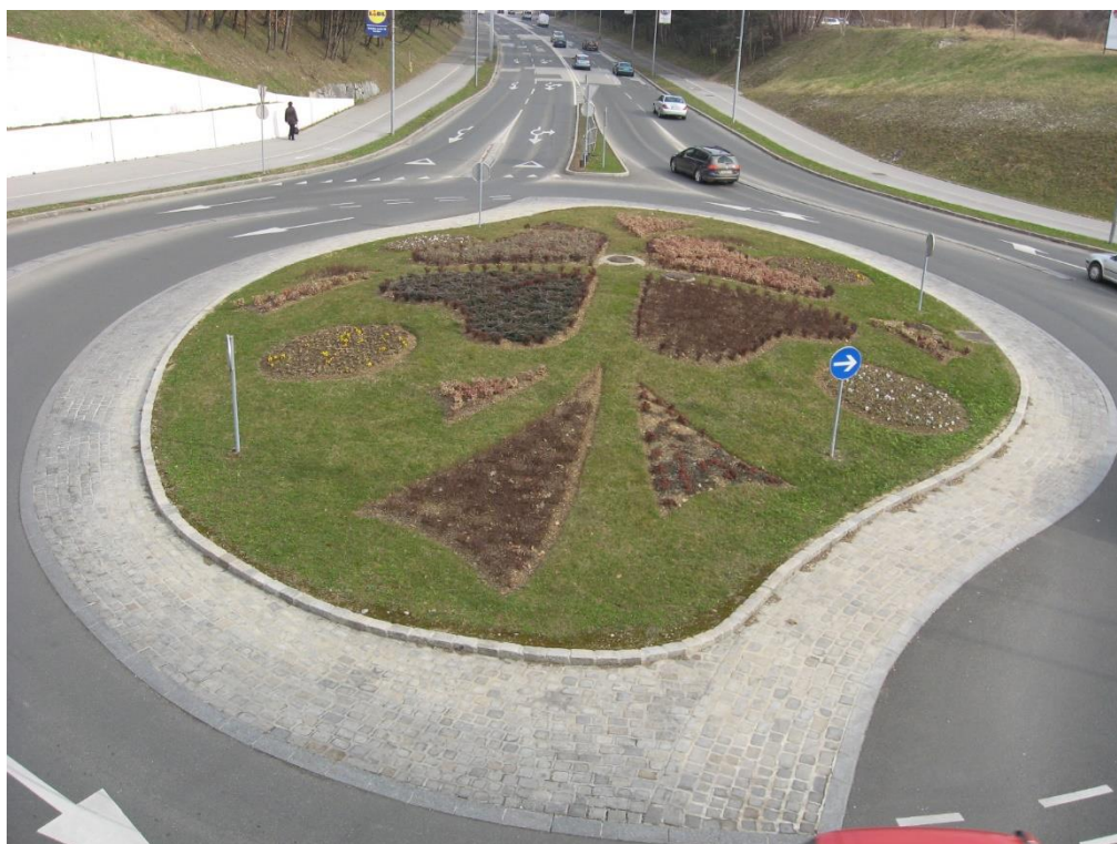
Slika 24: Pogled na celotno turbo-krožno križišče, z jasno vidnimi cestnimi in talnimi označbami ter sredinskih otokom, ki preprečuje pogled preko krožnega križišča
