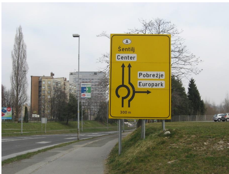
Slika 19: Opozorilna tabla, ki udeležencem v prometu omogoča pravočasno razvrstitev, da ne prihaja do prepletanja in omogoča večjo prepustnost, saj se udeleženci lahko še pravočasno odločijo za ustrezno razvrstitev
