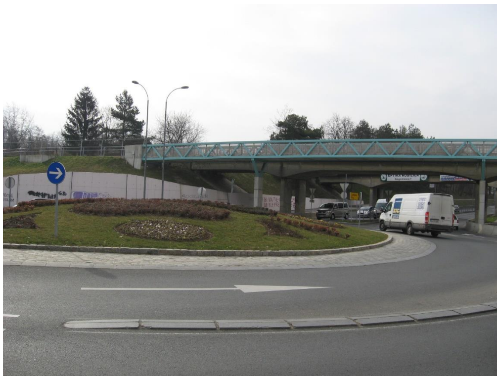
Slika 33: Deniveliran dvignjen otok za ločevanje pasov in ustrezna talna označba.
