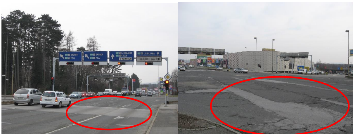
Slika 3: Prikaz slabega stanja talnih označb in uničenosti cestne površine
