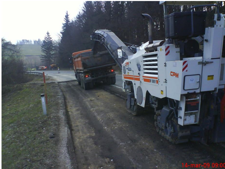
Slika 9: Rezanje asfalta
