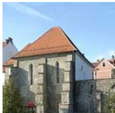
Slika 13: Del mestnega obzidja s sinagogo
