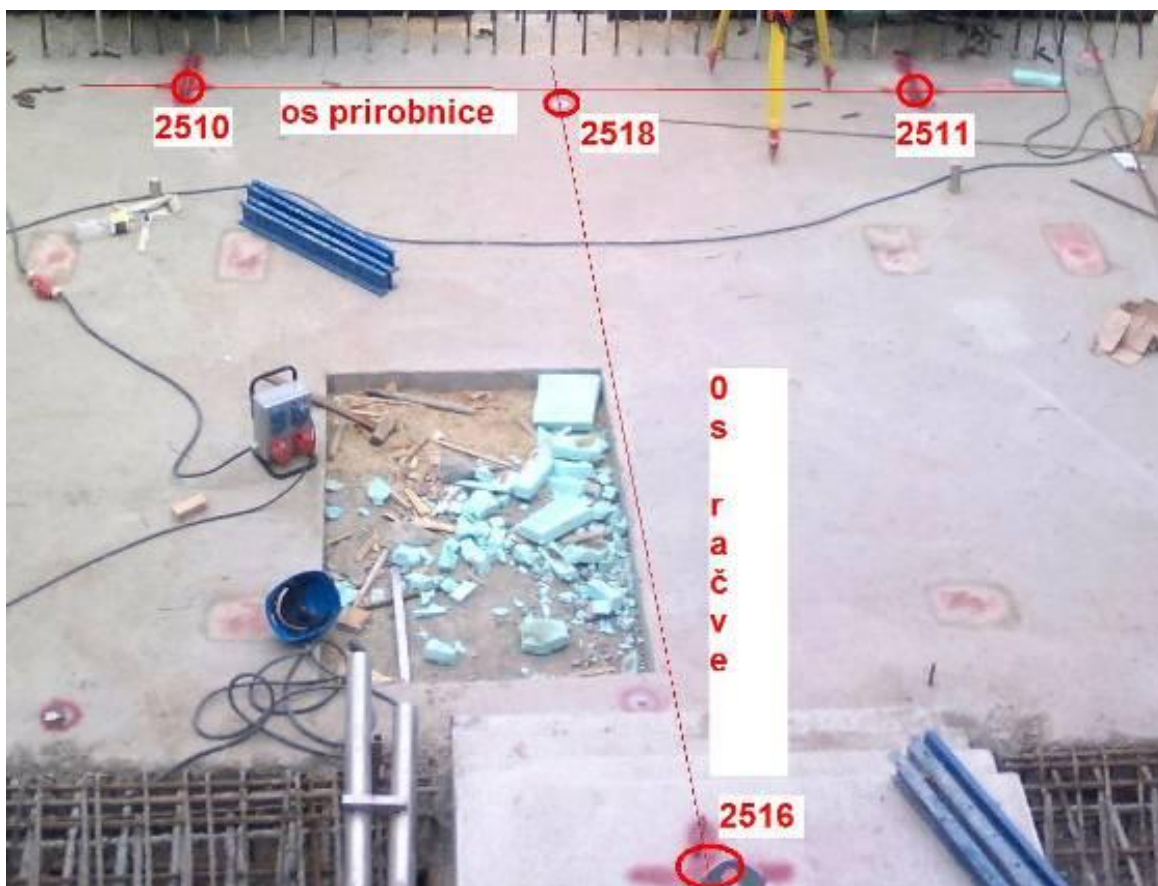
Slika 30: Primer zakoličenja na objektu MHE Markovci, kjer bodo vgradili turbine, za kar potrebujejo natančno zakoličenje za strojno montažo.
