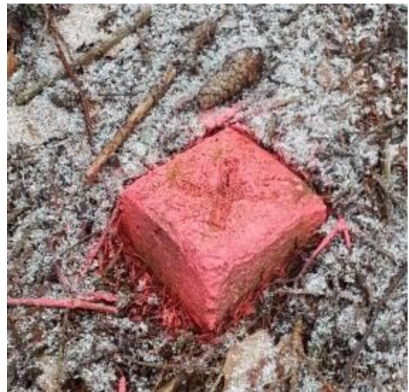
Slika 20: Mejnik s kovinskim sidrom ter betonski mejnik s križem
