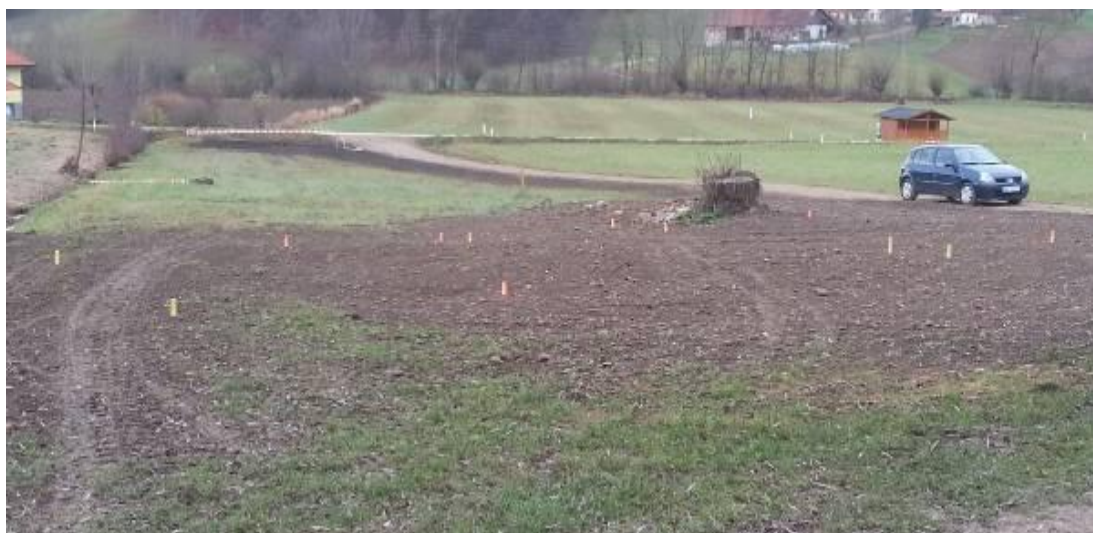
Slika 27: Enostavno zakoličenje hiše s količki
