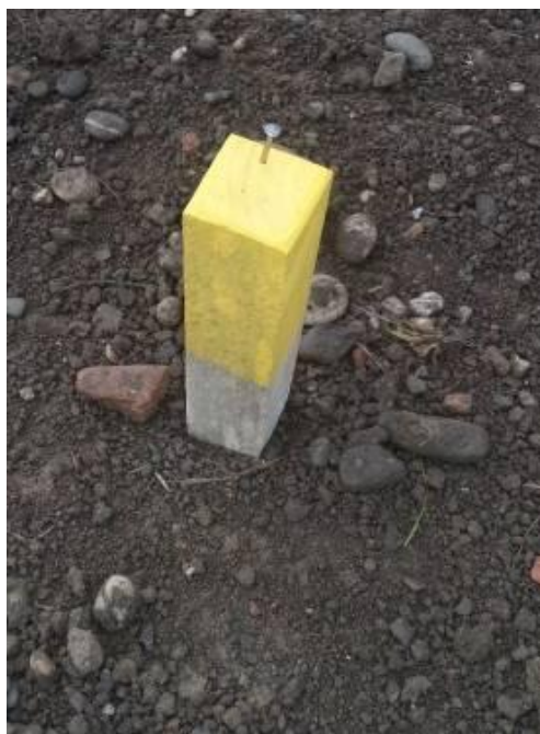
Slika 26: Zakoličenje vogalne točke objekta na količek
