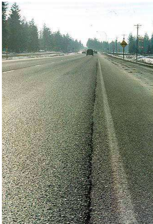
Slika 13: Primer vzdolžne razpoke na stiku
