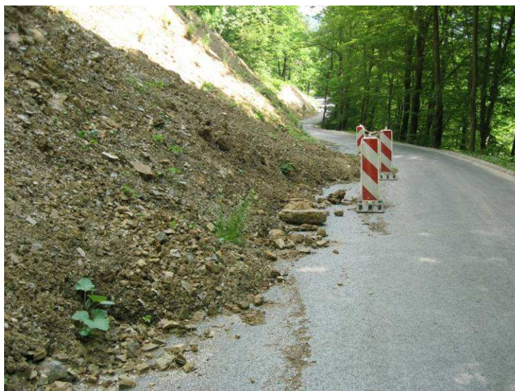
Slika 3: Primer zdrsa pobočja Vir: Interno gradivo podjetja XY
