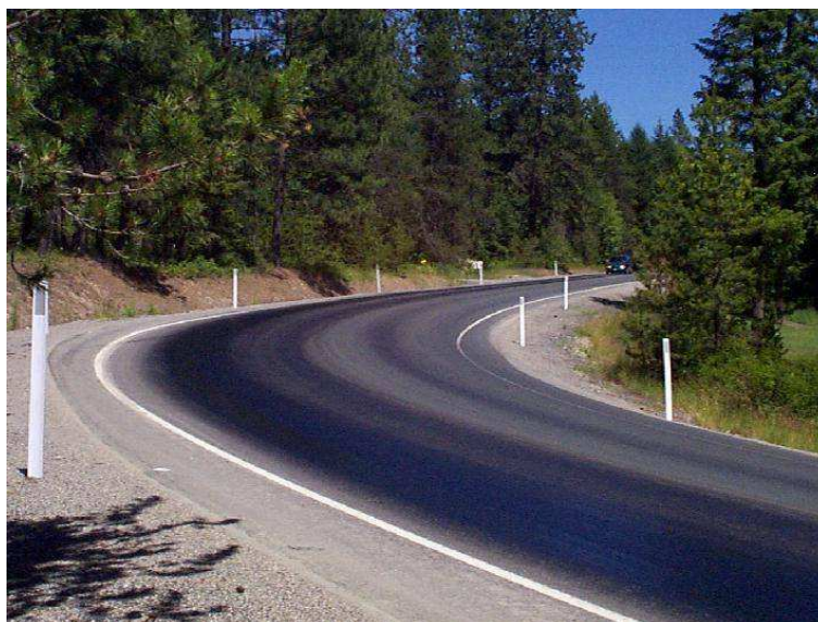
Slika 10: Primer izstopanja bitumenskega veziva na površino vozišča
