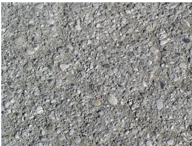
Slika 11: Primer zglajenosti površine
