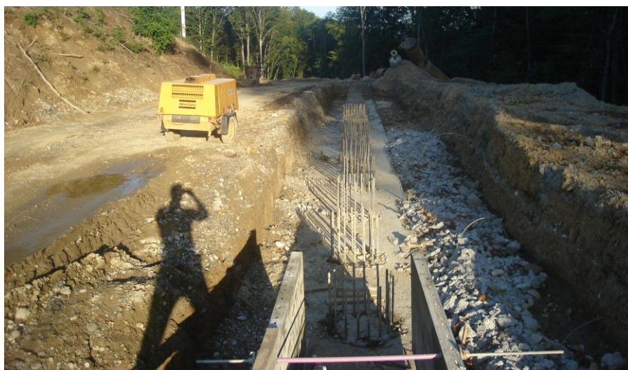
Slika 2: Primer pilotne konstrukcije pred betoniranjem vezne grede
