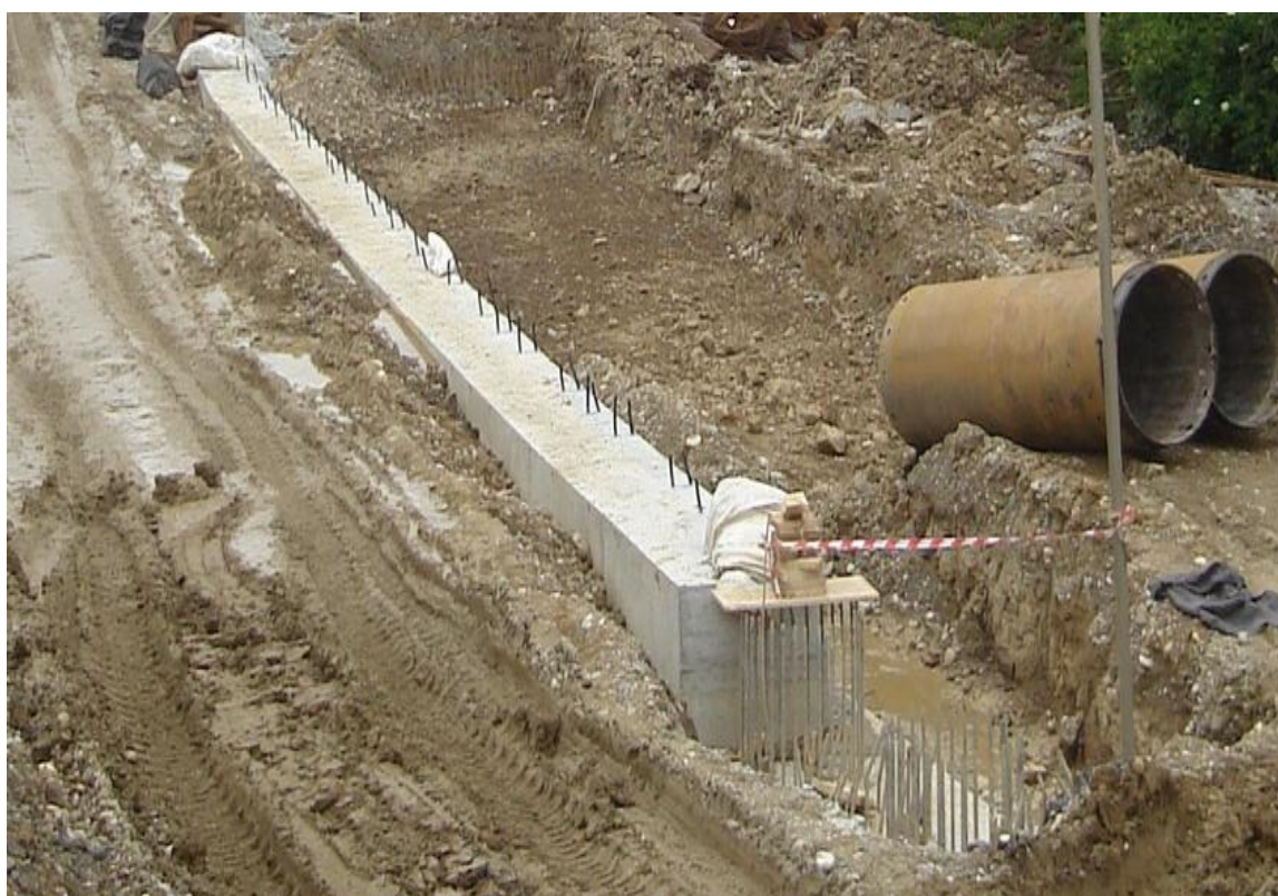
Slika 14: Primer betonirane AB grede
