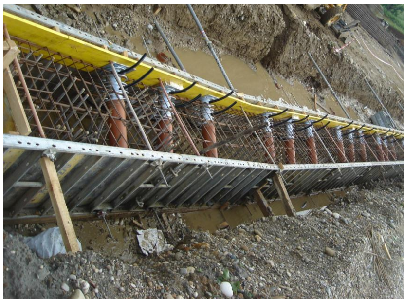
Slika 13: Primer vgrajenih tulcev sidrane AB grede pred betoniranjem
