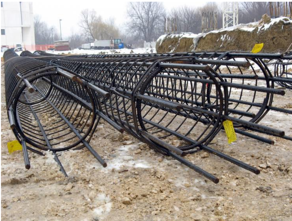
Slika 8: Primer armaturnih košev
