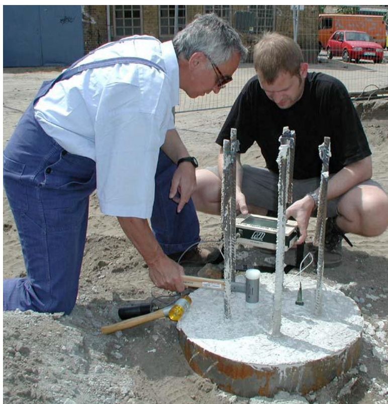
Slika 16: Primer izvedbe PIT testa na pilotu
