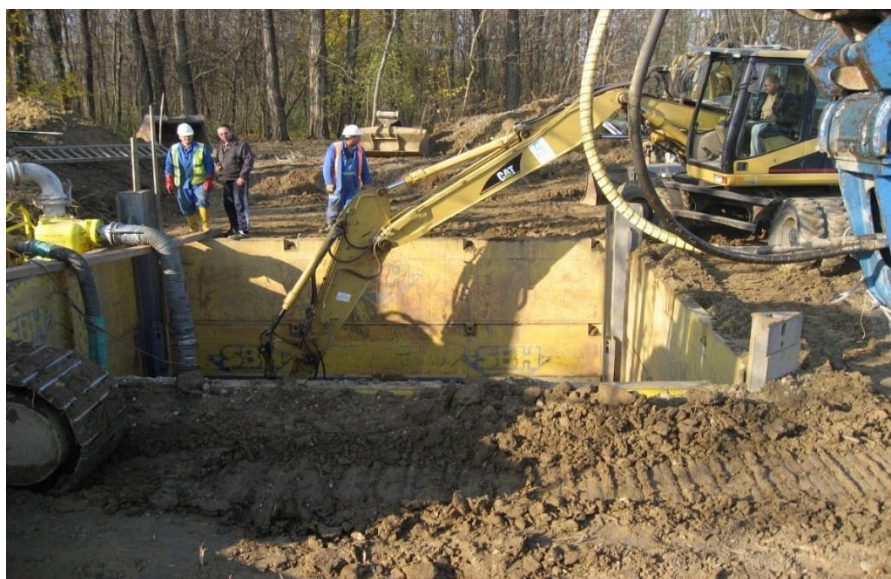
Slika 21: Izkop črpališča Č1D
