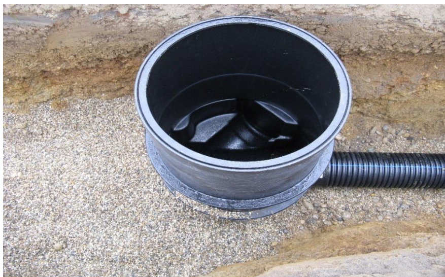
Slika 18: Zasip jaška s frakcijo 8–16
