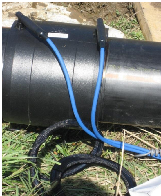
Slika 20: Elektrofuzijsko varjenje tlačnih cevi
