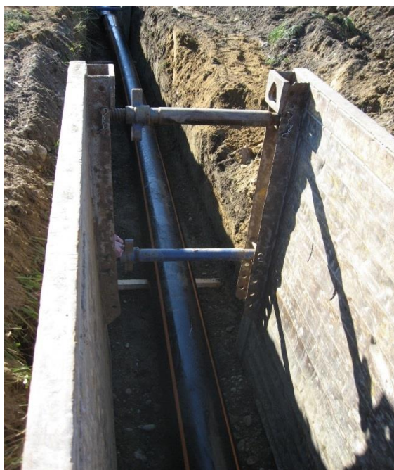
Slika 19: Položene tlačne cevi
