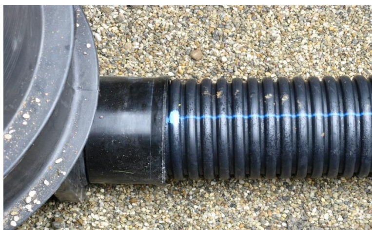
Slika 17: Spoj cevi DN200 na jašek DN800
