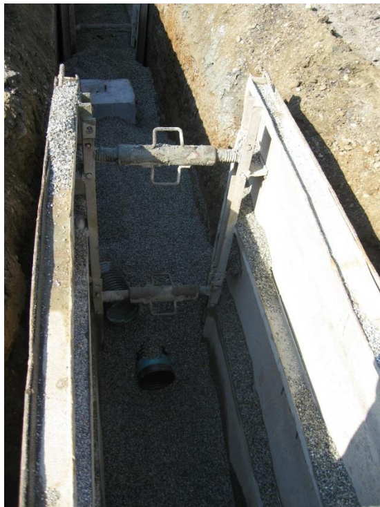
Slika 16: Na sliki viden betonski prstan, zagatnice in položena cev, zasipana s frakcijo
