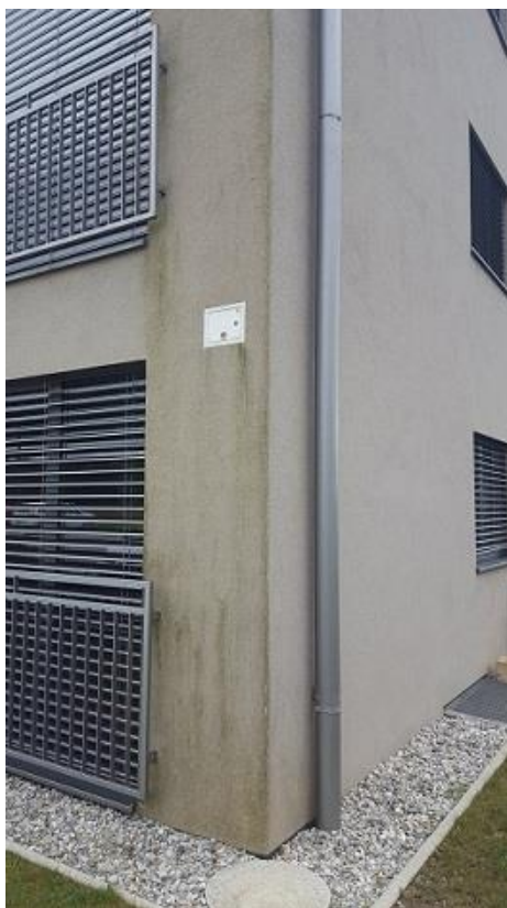
Slika 13: Sledi plesni in alg na severni strani objekta
