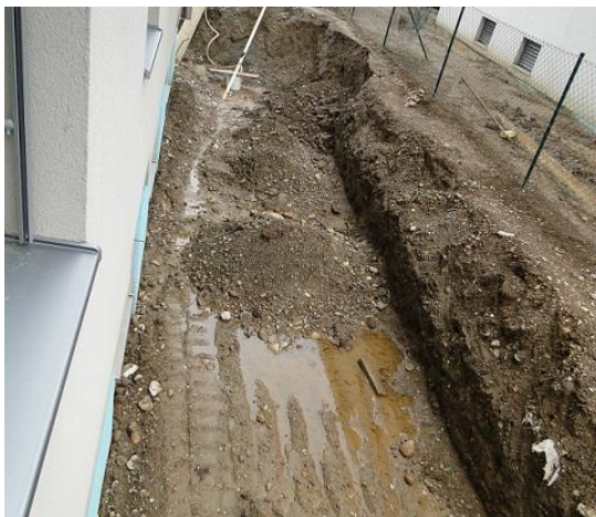
Slika 2: Zunanja sanacija objekta
