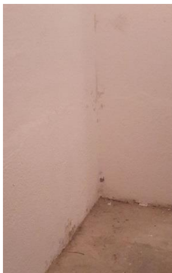
Slika 3: Kapilarna vlaga v kletnih prostorih
