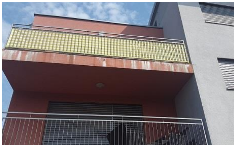
Slika 10: Sledi solitra na južni strani objekta
