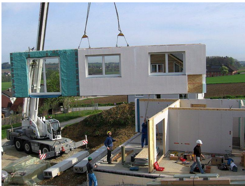
Slika 3: Tehnologija montažne lesene gradnje s sendvič paneli
