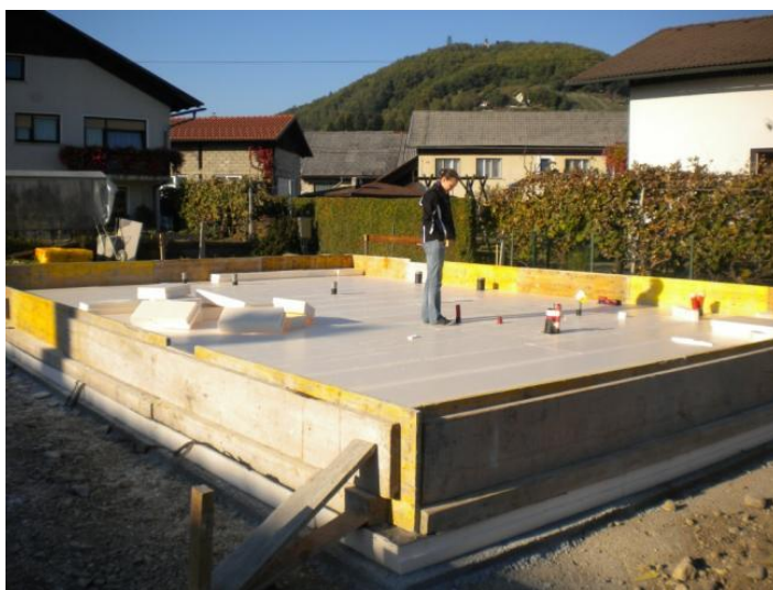
Slika 6: Položena toplotna izolacija iz XPS na podbetonu in izdelan opaz temeljne plošče
