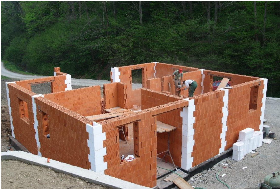
Slika 7: Nosilni in predelni zidovi iz opečnih zidakov
